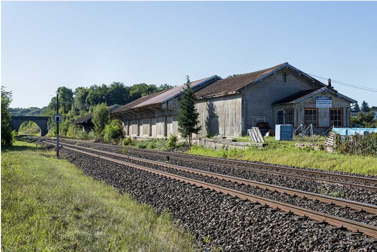
La voie ferrée et l'ancienne halle à marchandises.
