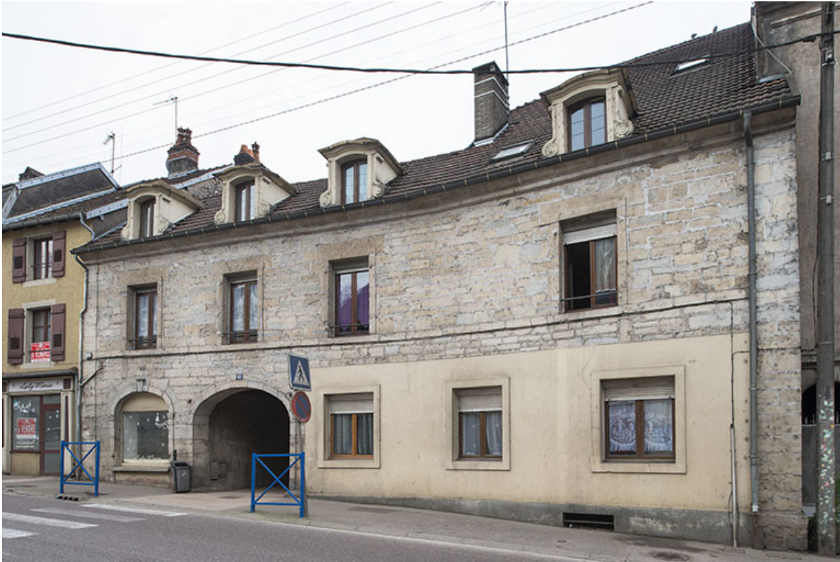
La façade principale depuis la rue.
