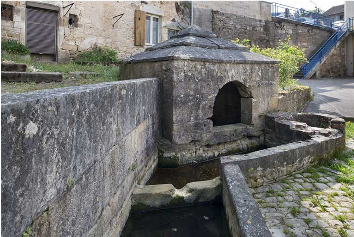
Le puisard et le canal alimentant les bassins.
