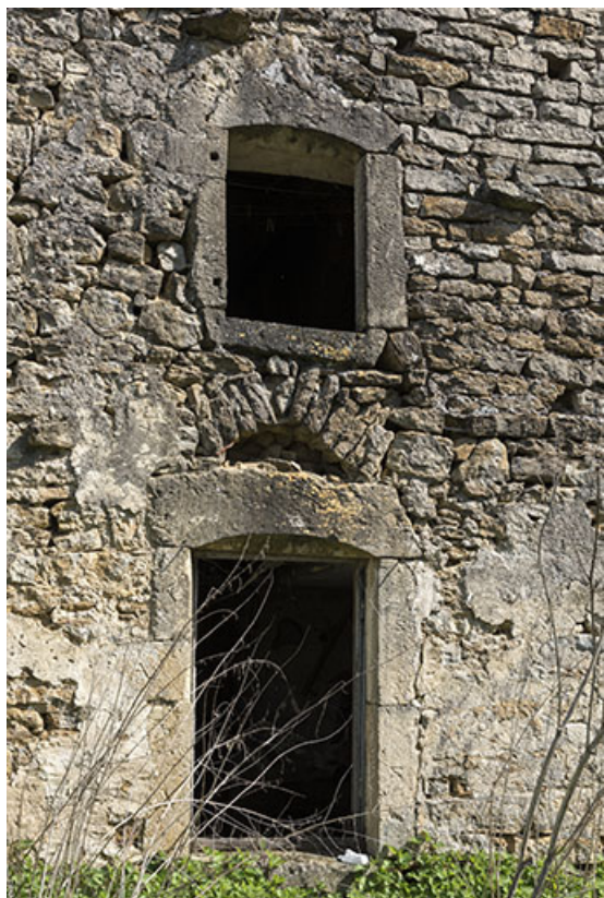
Détail de baies du pignon sud-ouest. (25 route de Vittel.) 70, Betaucourt
