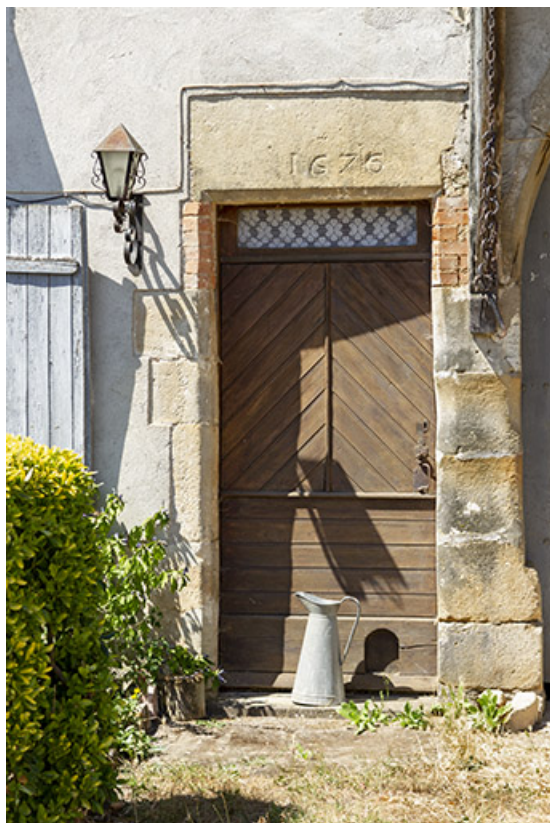
Détail de la porte et du linteau. (4 rue du Château.) 70, Cendrecourt
