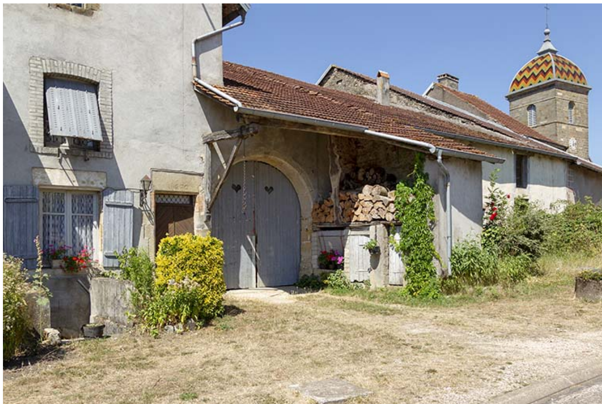
Ferme en haut (4) de la rue du Château. 70, Cendrecourt
