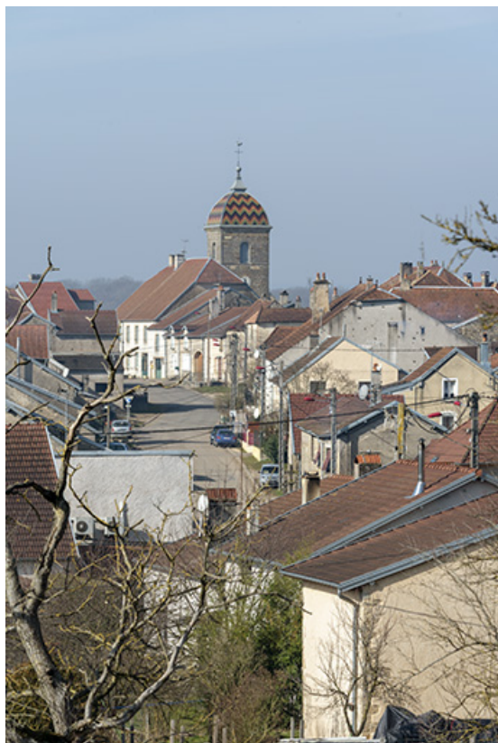
Vue du village depuis l'est. Rue du jardiney. 70, Cendrecourt
