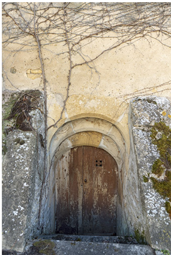
Entrée de cellier à arc en plein cintre, à ressauts formé de trois rouleaux. 70, Cendrecourt
