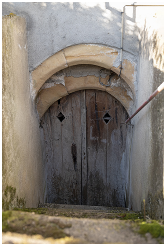
Entrée de cellier à arc en plein cintre, à ressauts formé de deux rouleaux. 70, Cendrecourt
