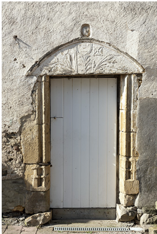
Ferme à l'ouest de l'ancienne cure (parcelles cadastrées D 562 et 446) : tympan en plein cintre décoré d'oiseaux et de feuillages en relief écrasé remployé comme linteau d'une porte aux piédroits moulurés. 70, Cendrecourt
