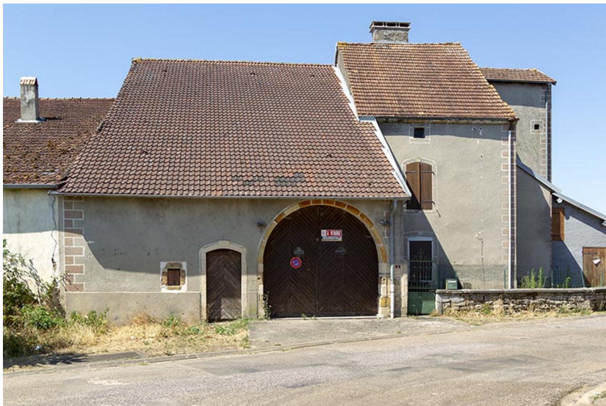
Façade antérieure, porte de grange et porte piétonnière, 2 rue du Château. 70, Cendrecourt
