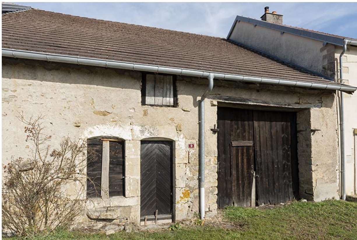
Façade de ferme à linteaux délardés, 9 route de Vénisey. (Départementale 46) 70, Cendrecourt
