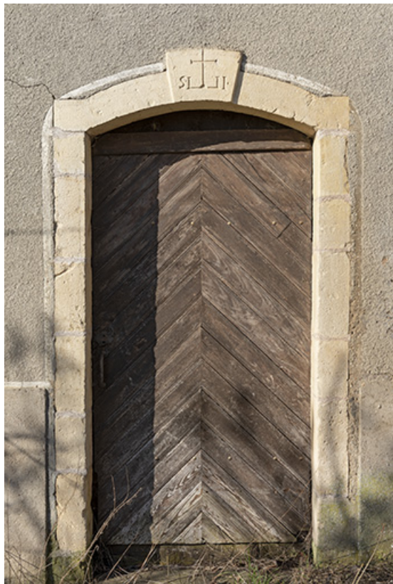
Porte d'entrée ornée d'une clé portant inscription dans le linteau. (Détail de la maison 2 rue du Château) 70, Cendrecourt
