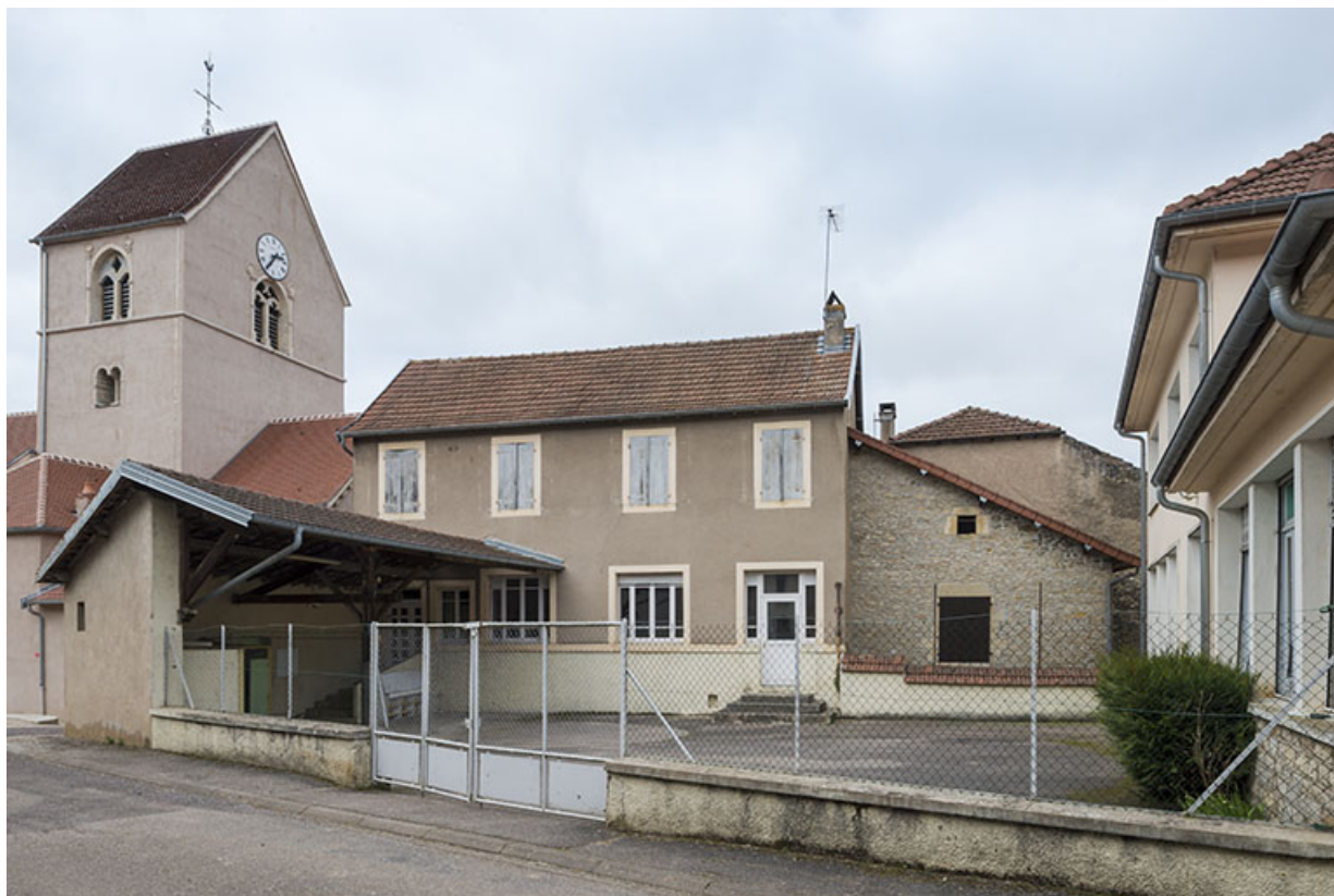
L'ancienne maison d'école des filles.
