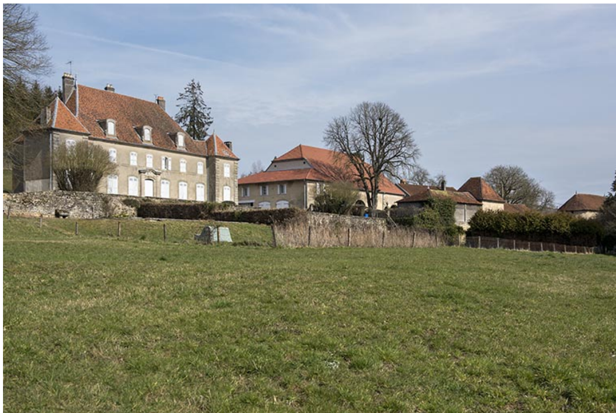
Vue de trois-quart de l'ensemble du château et des bâtiments d'exploitation agricole, vu du sud-ouest. 70, Ranzevelle
