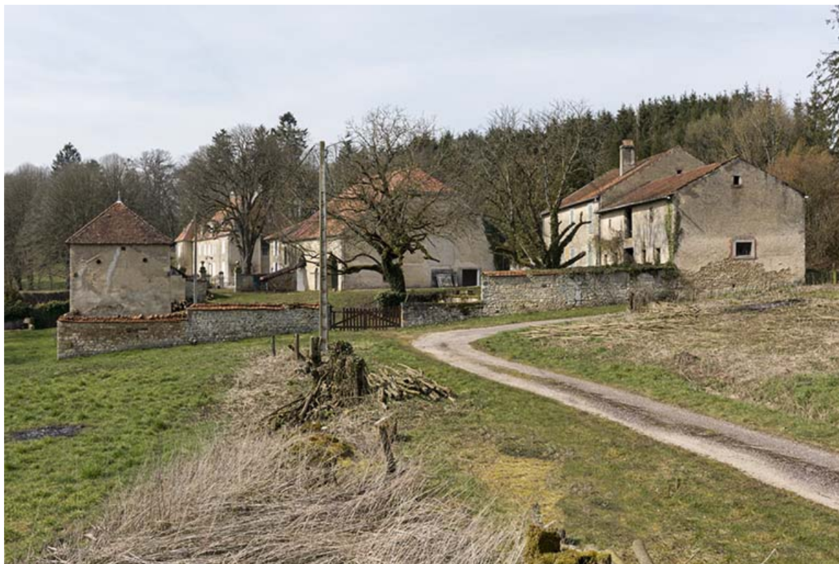
Vue d'ensemble du château et des bâtiments d'exploitation agricole depuis l'est. 70, Ranzevelle
