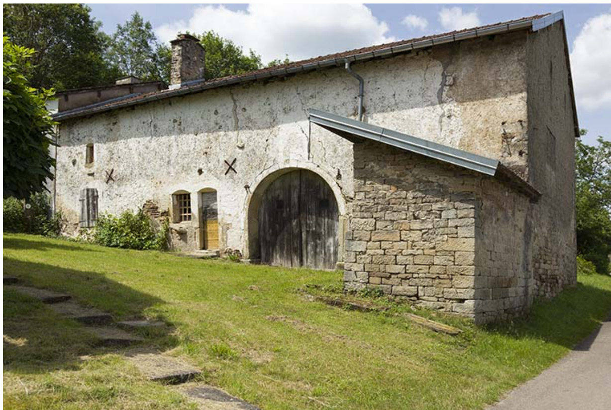
Ferme, perpendiculaire à la rue Principale (au 15.)
