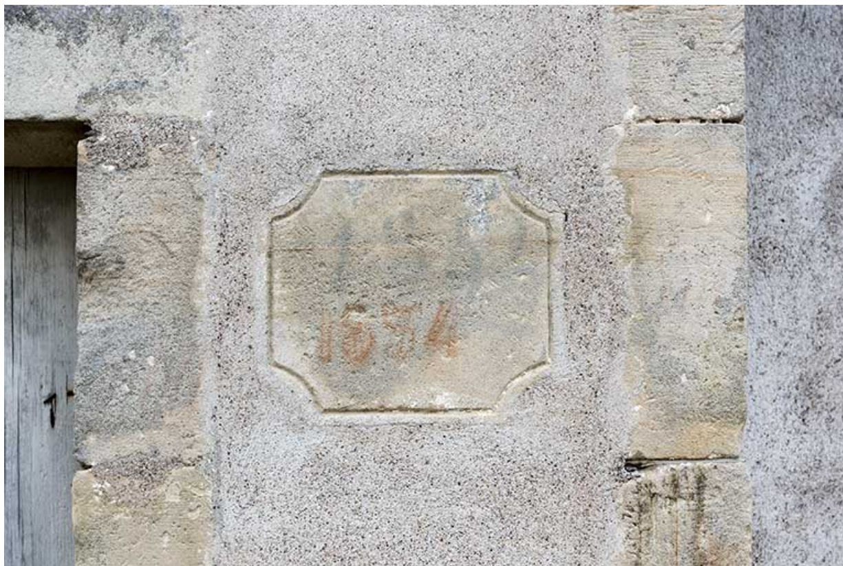
Détail de pierre de fondation de la façade de la ferme 9 rue Principale.
