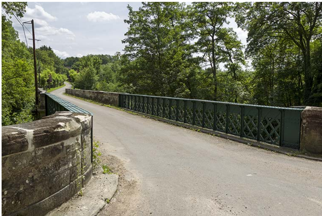
Vue de la passerelle depuis la route.
