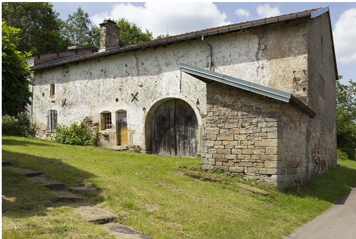
Ferme, perpendiculaire à la rue Principale (au 15.)
