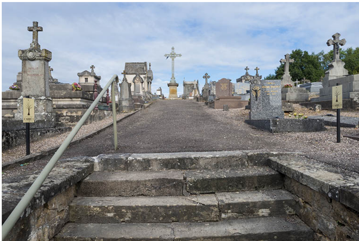
La volée de marches conduisant vers l'allée principale.
