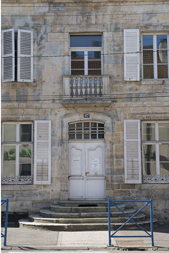
Vue de la travée principale, façade antérieure.
