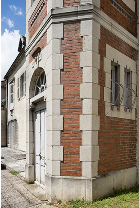
Base de la tourelle avec jeux de chaînages en pierre de taille.
