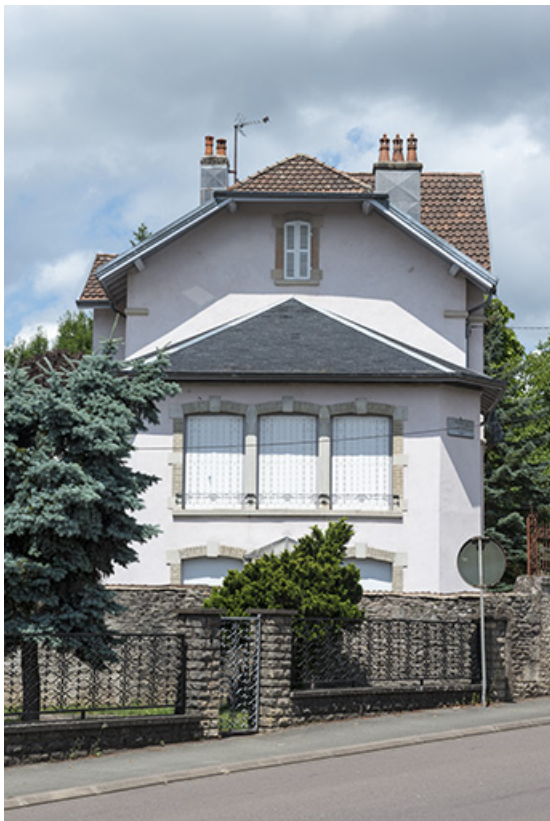
La façade sud, depuis le bas de la rue. 70, Port-sur-Saône, 10 avenue de la Gare
