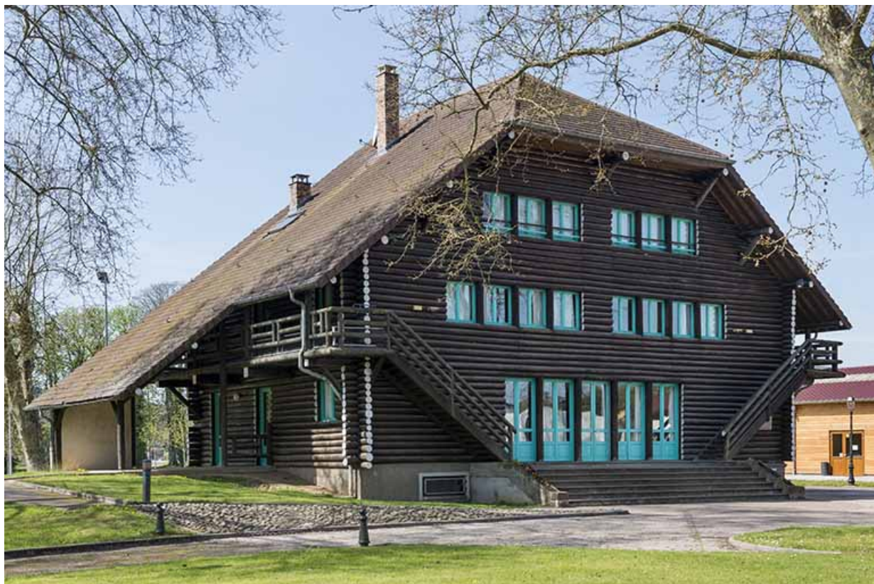
Vue d'ensemble. 70, Port-sur-Saône
