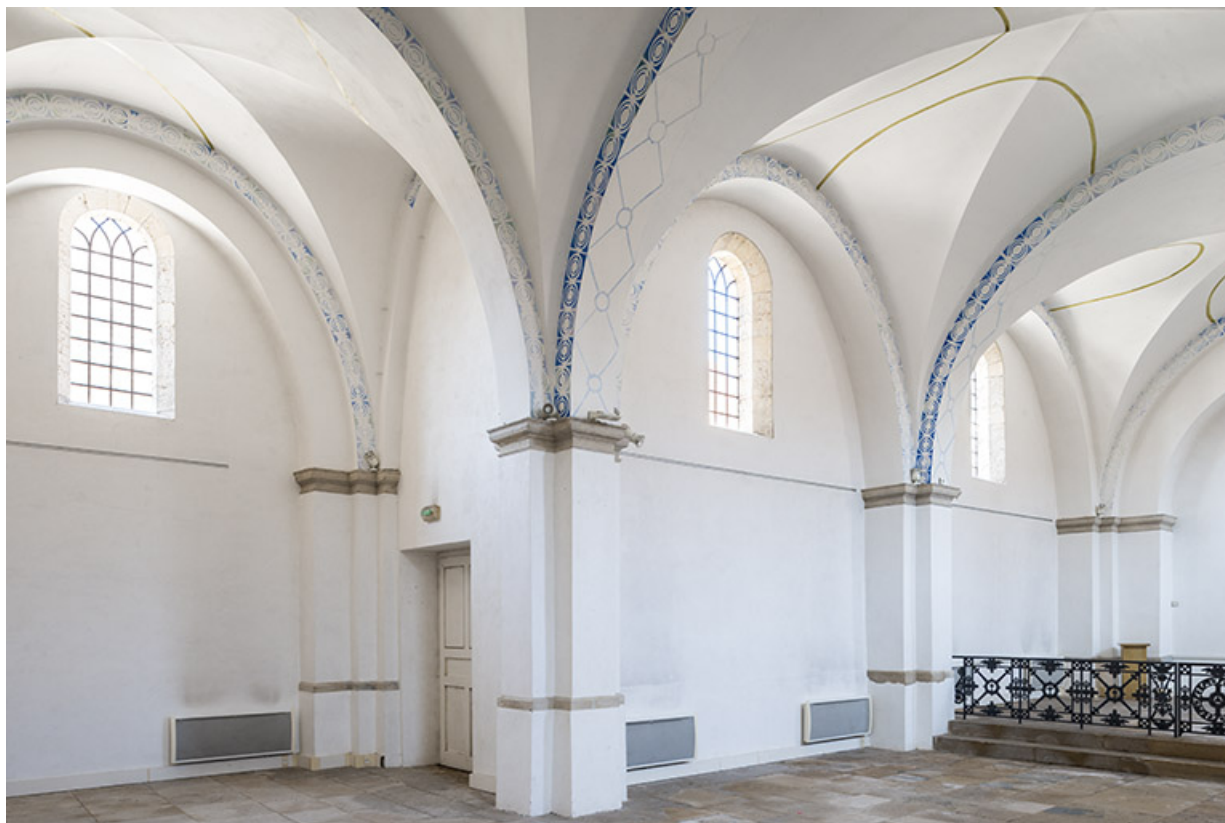
Le mur ouest de la nef.
