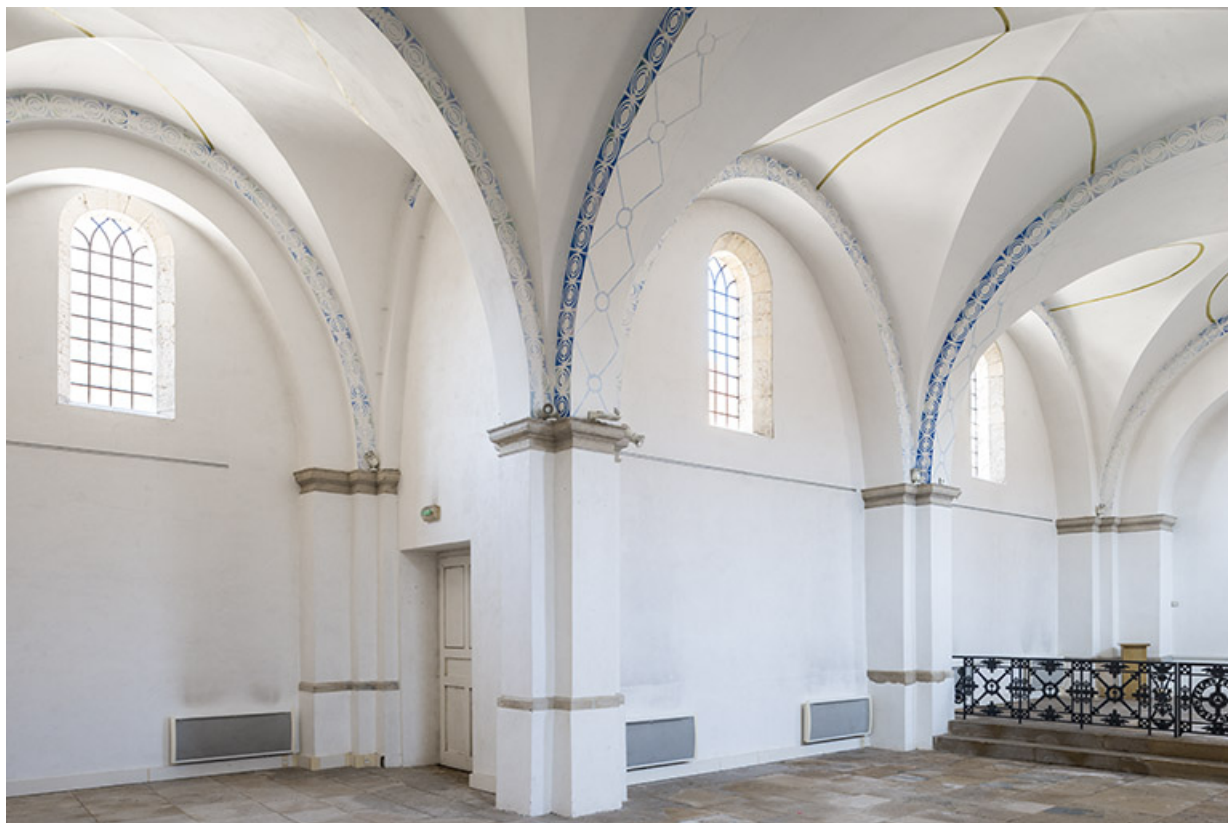
Le mur ouest de la nef.
