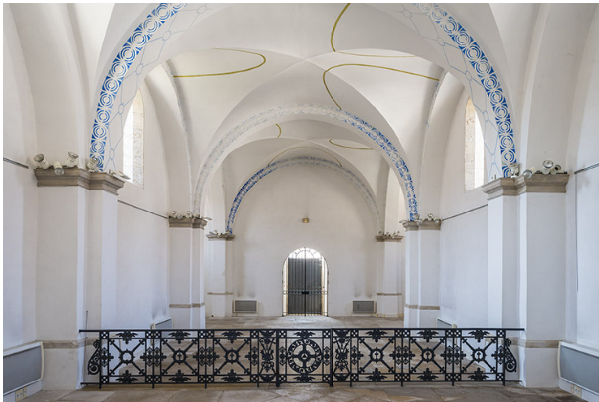
Vue générale depuis le chœur.
