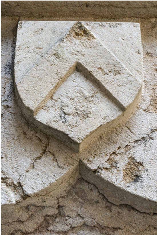
Blason situé au dessus de la porte d'accès à la tour depuis la cour intérieure. 70, Port-sur-Saône rue de l' Église
