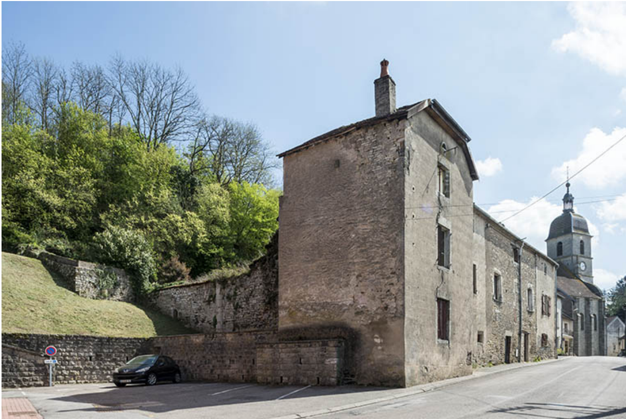
vue générale (depuis le nord) des bâtiments conventuels, rue de l'Église. 70, Port-sur-Saône rue de l'Église
