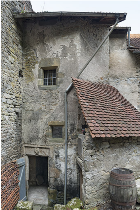
Tour comprenant l'escalier, côté cour.
