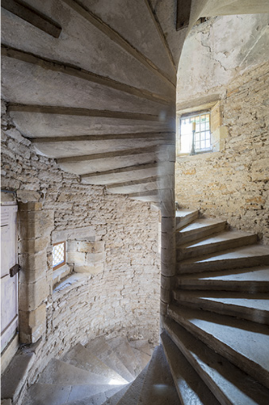
Escalier suspendu, vue depuis le premier étage. 70, Port-sur-Saône rue de l'Église
