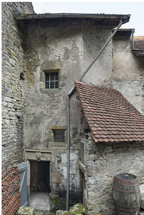
Tour comprenant l'escalier, côté cour.
