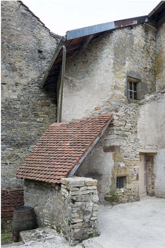
La tour depuis l'ancien cloître. 70, Port-sur-Saône rue de l'Église
