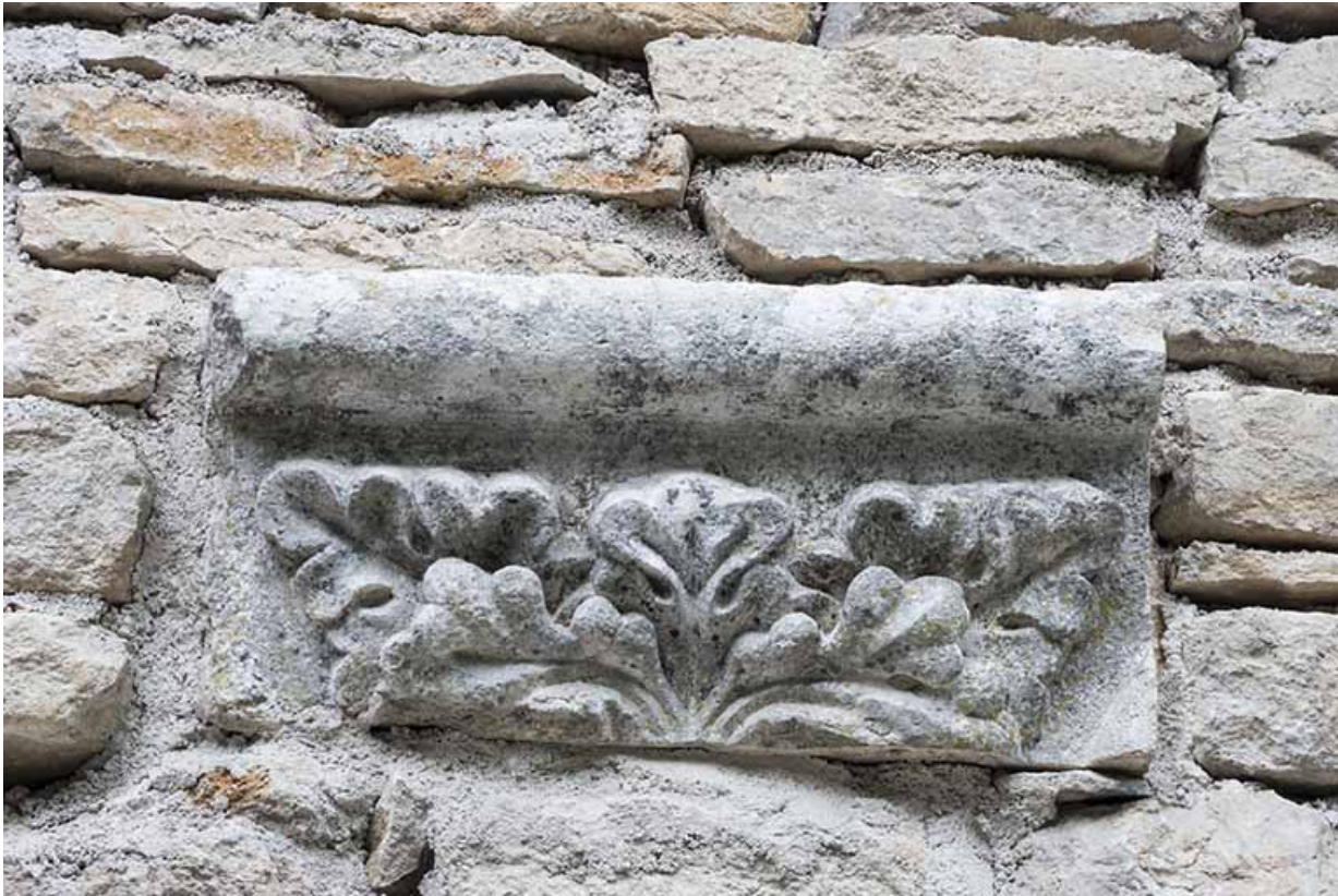
Fragment d'un chapiteau, façade côté cour. 70, Port-sur-Saône rue de l'Église
