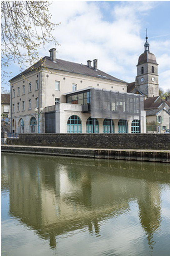
La façade postérieure et le clocher de l'église.
