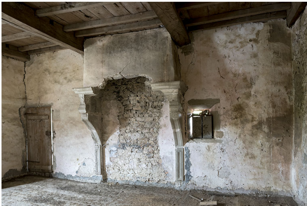
Cheminée adossée, à l'étage de l'ancien logis. 70, Vouécourt
