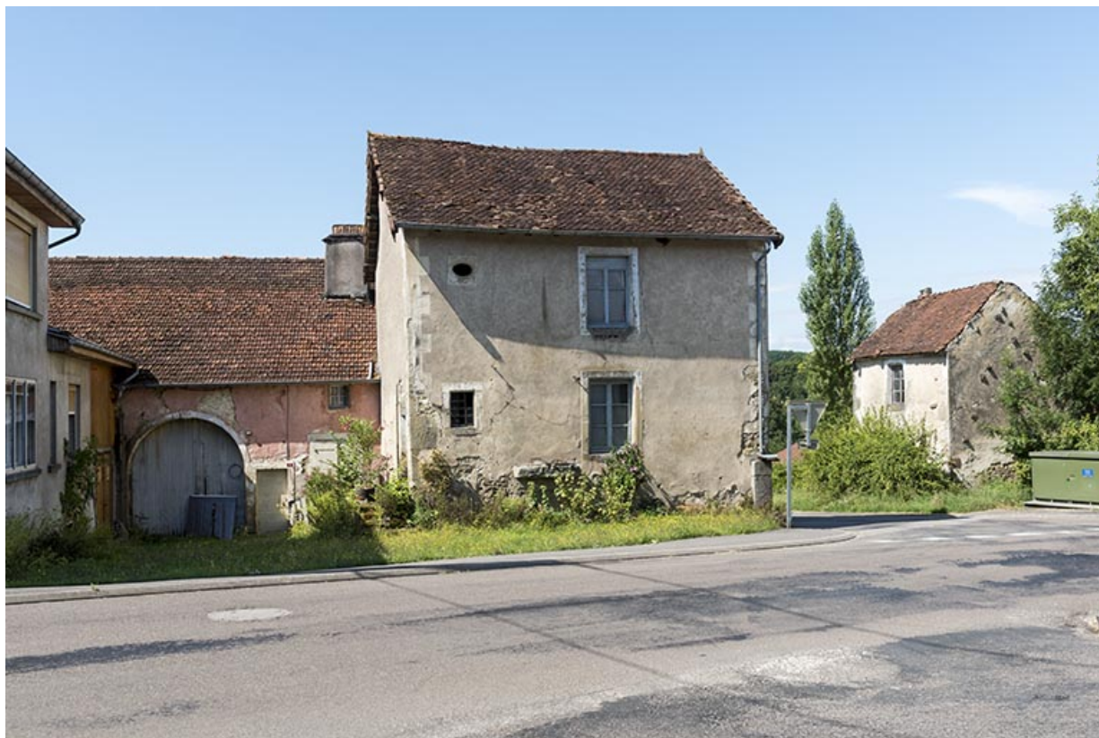
Les façades nord est à l'angle des rue des Vosges et rue du moulin. 70, Vougécourt
