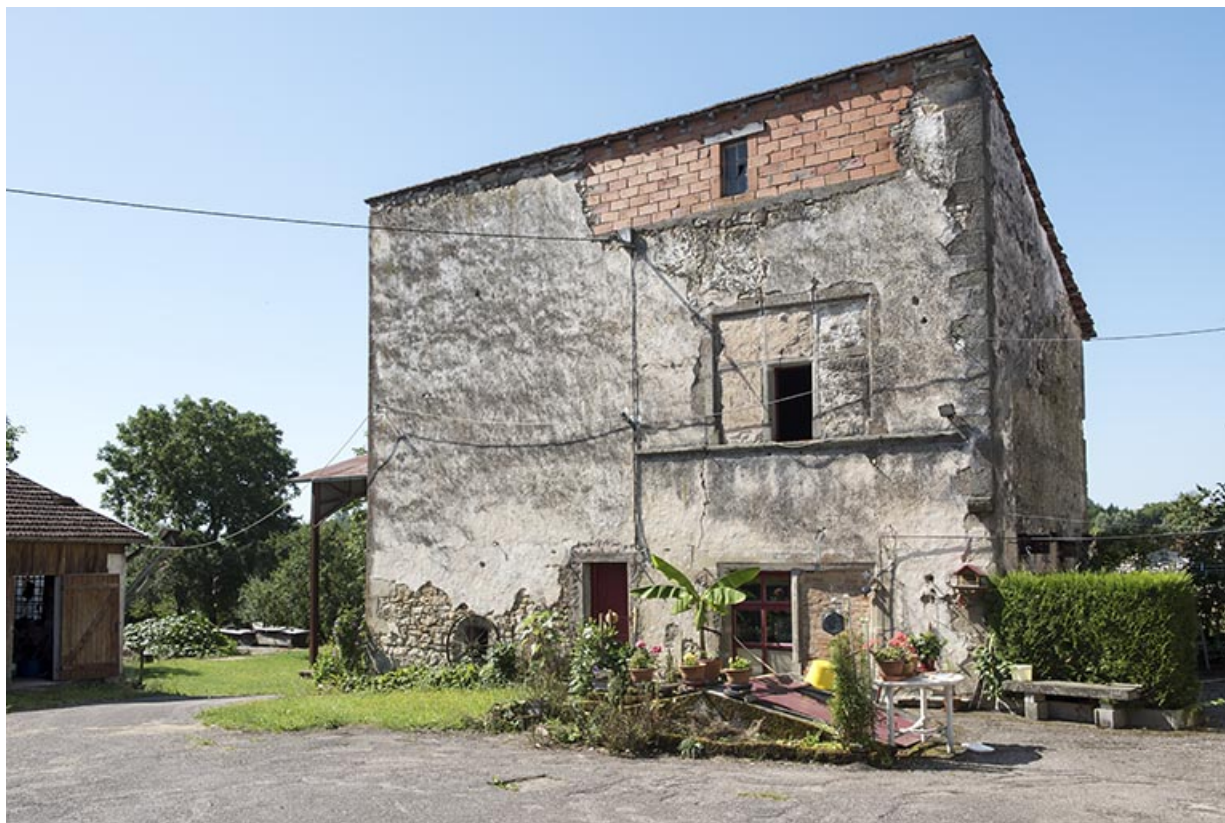
Ancien logis vu du nord-est. 70, Vouécourt
