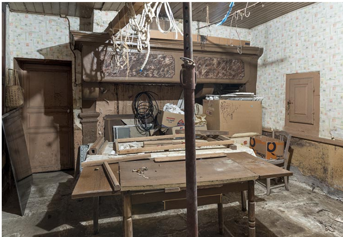
Rez-de-chaussée de la maison en fond de cour, sud-ouest. Cheminée adossée. 70, Vouécourt
