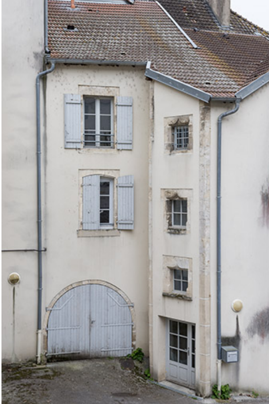
Détail d'une travée. 70, Port-sur-Saône
