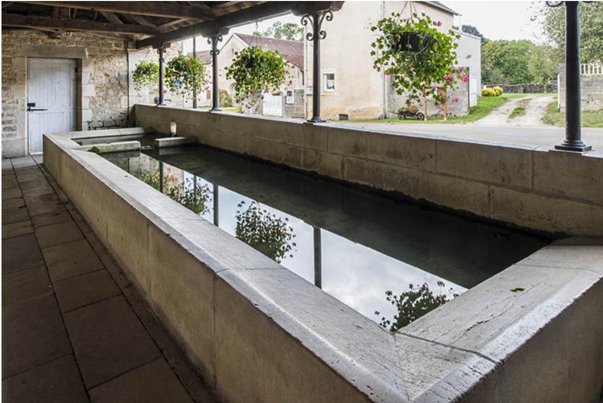
Le bassin à usage de lavoir.
