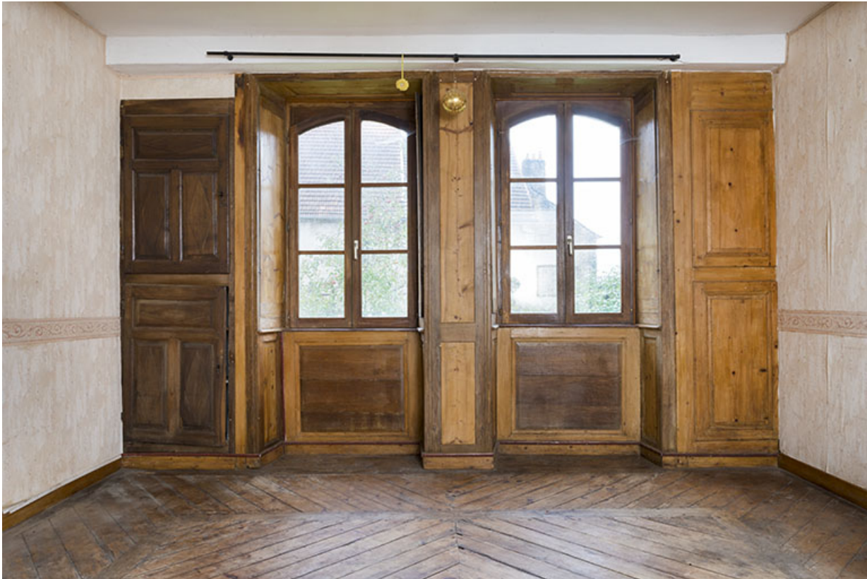
Détail des fenêtres ayant conservé leurs boiseries: plintes, encadrements, retours de fenêtres, volets intérieurs et placards 70, Baulay, 32-34 Grande Rue
