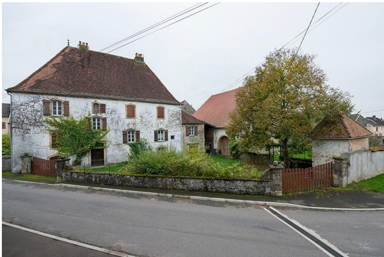
L'ensemble de la propriété, maison, grange, pigeonnier et mur de clôture, depuis la mairie. 70, Baulay, 32-34 Grande Rue
