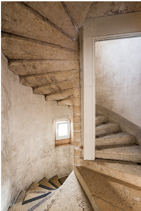
Escalier à vis, situé dans la tour.
