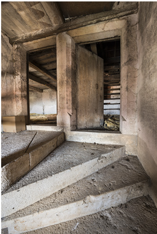
Portes d'accès aux combles depuis la tour.
