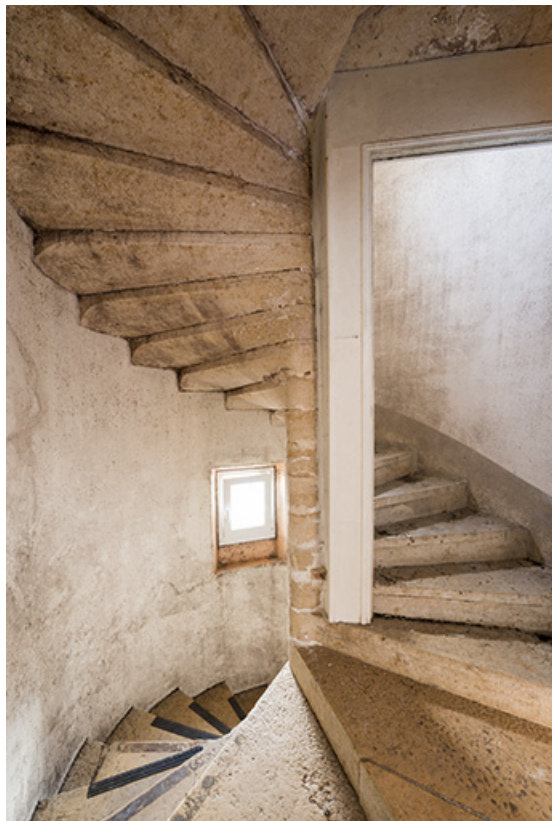
Escalier à vis, situé dans la tour.
