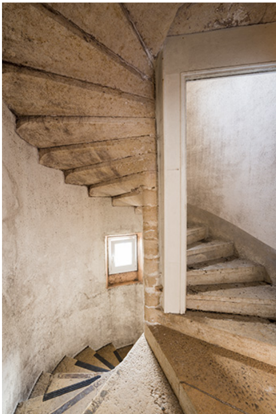
Escalier à vis, situé dans la tour.
