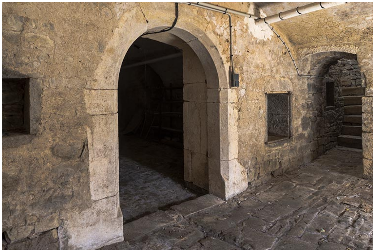
Porte de séparation de la cave.
