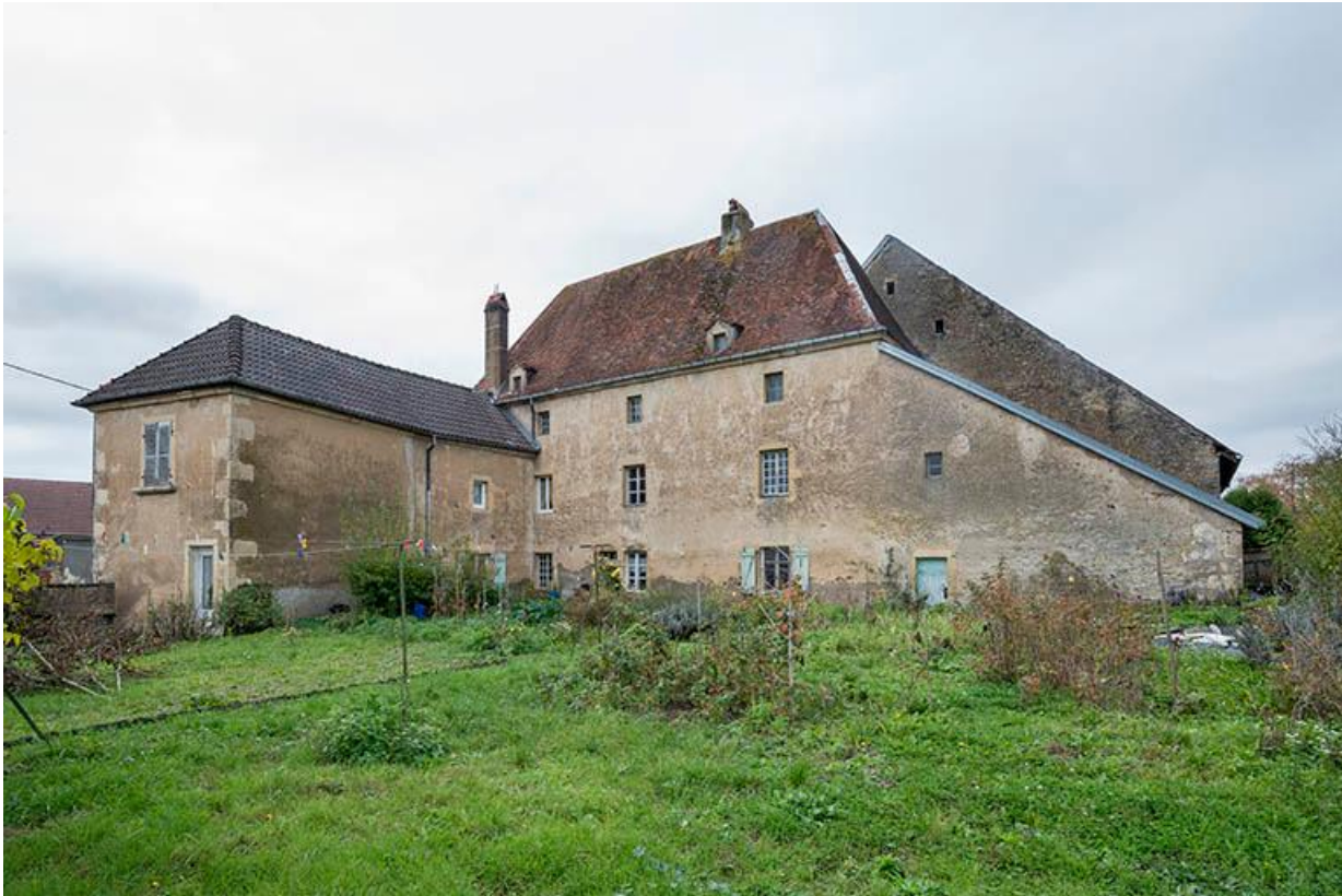
Ferme 13 Grande rue, vue depuis la voie ferrée. 70, Baulay
