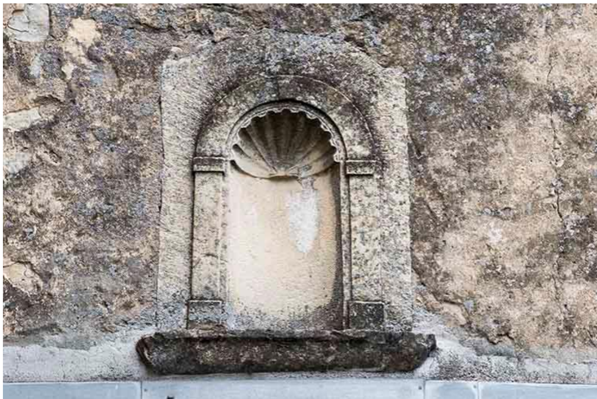
Niche située au-dessus de la porte d'entrée de l'habitation, 13 Grande rue. 70, Baulay
