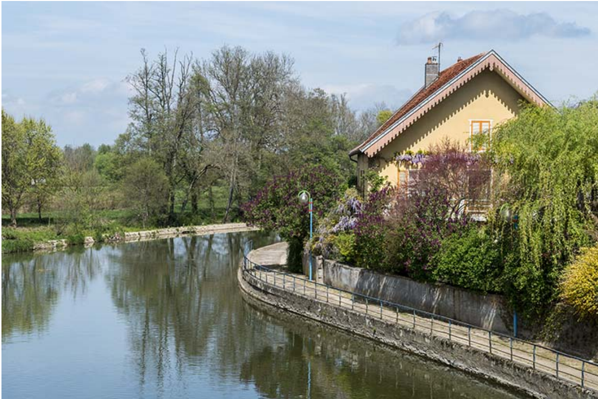
Vue sur le canal en amont de la porte de garde. 70, Port-sur-Saône
