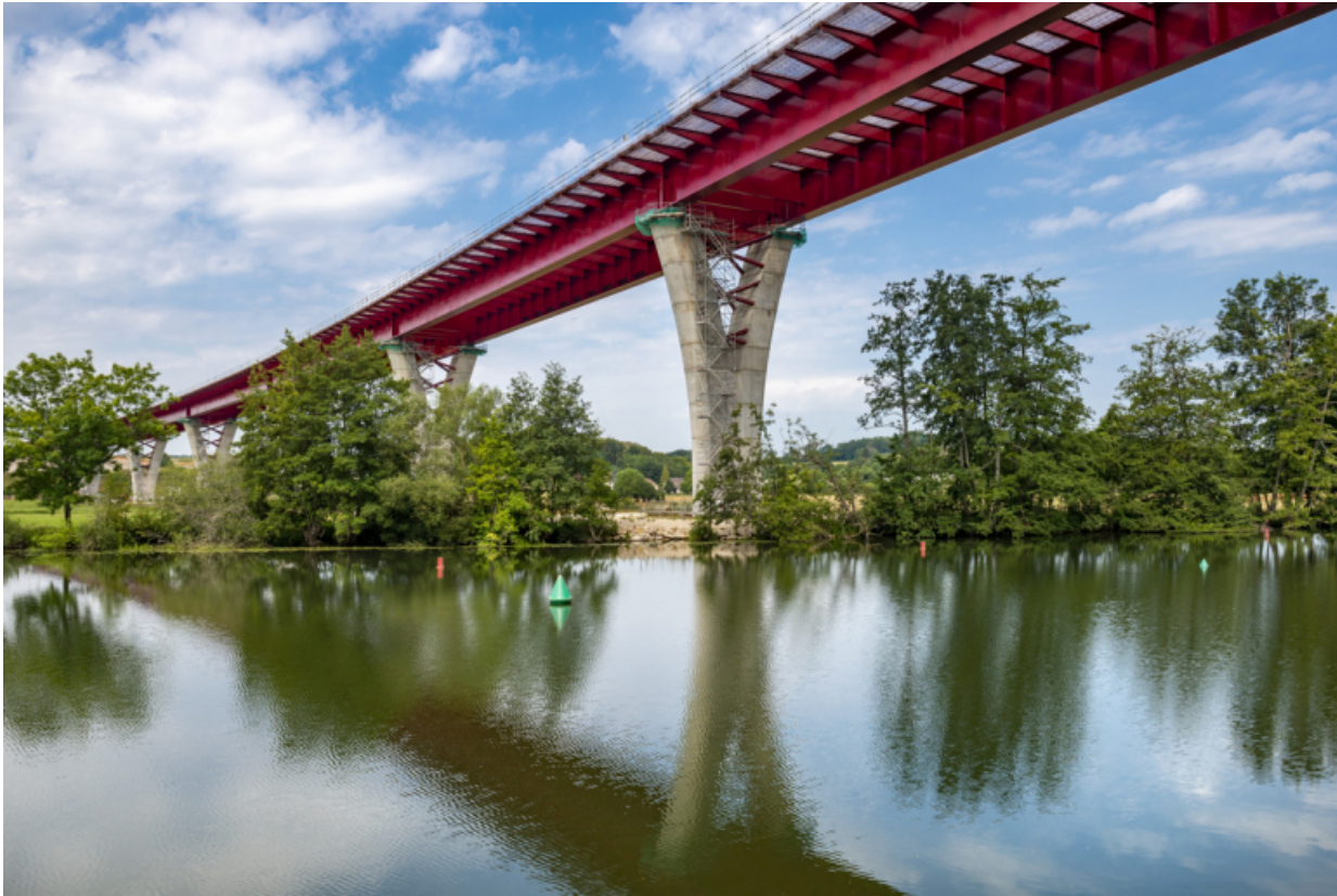
le viaduc en construction (déviation de Port-sur-Saône). 70, Port-sur-Saône
