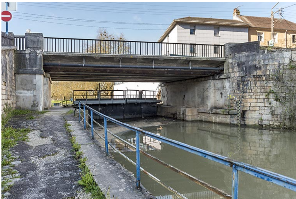
La porte de garde, vue depuis l'amont. 70, Port-sur-Saône
