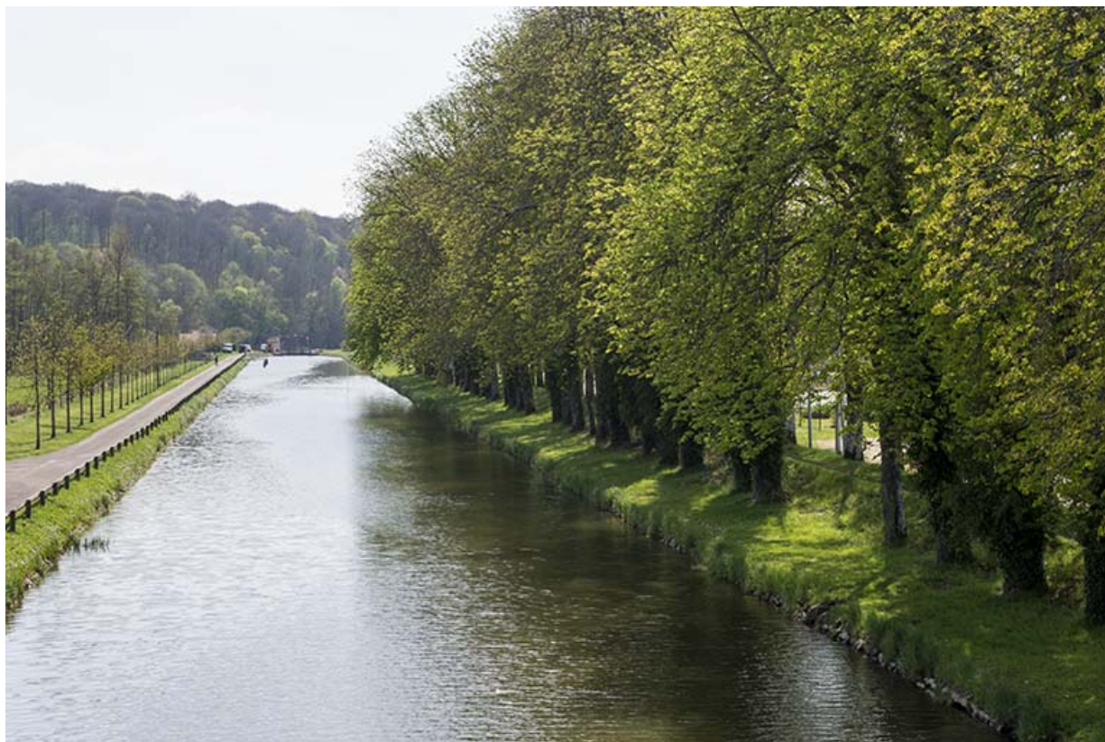
Vue générale du canal vers l'aval.
