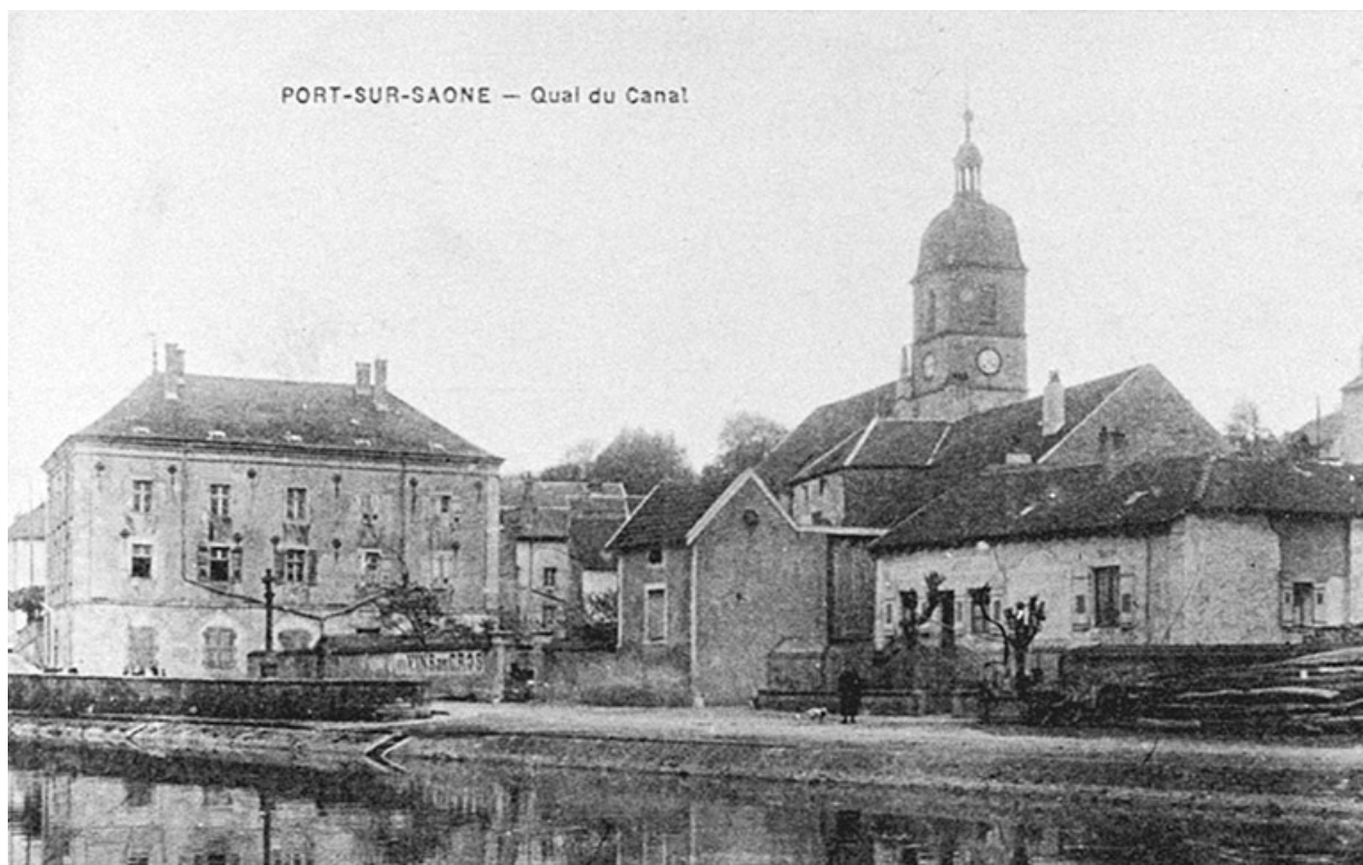
Les quais du canal derrière la mairie, carte postale.
