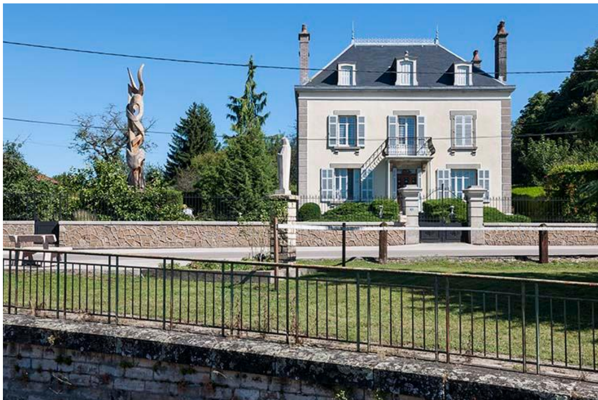
Maison 11 rue Grande vue depuis la voie ferrée.
