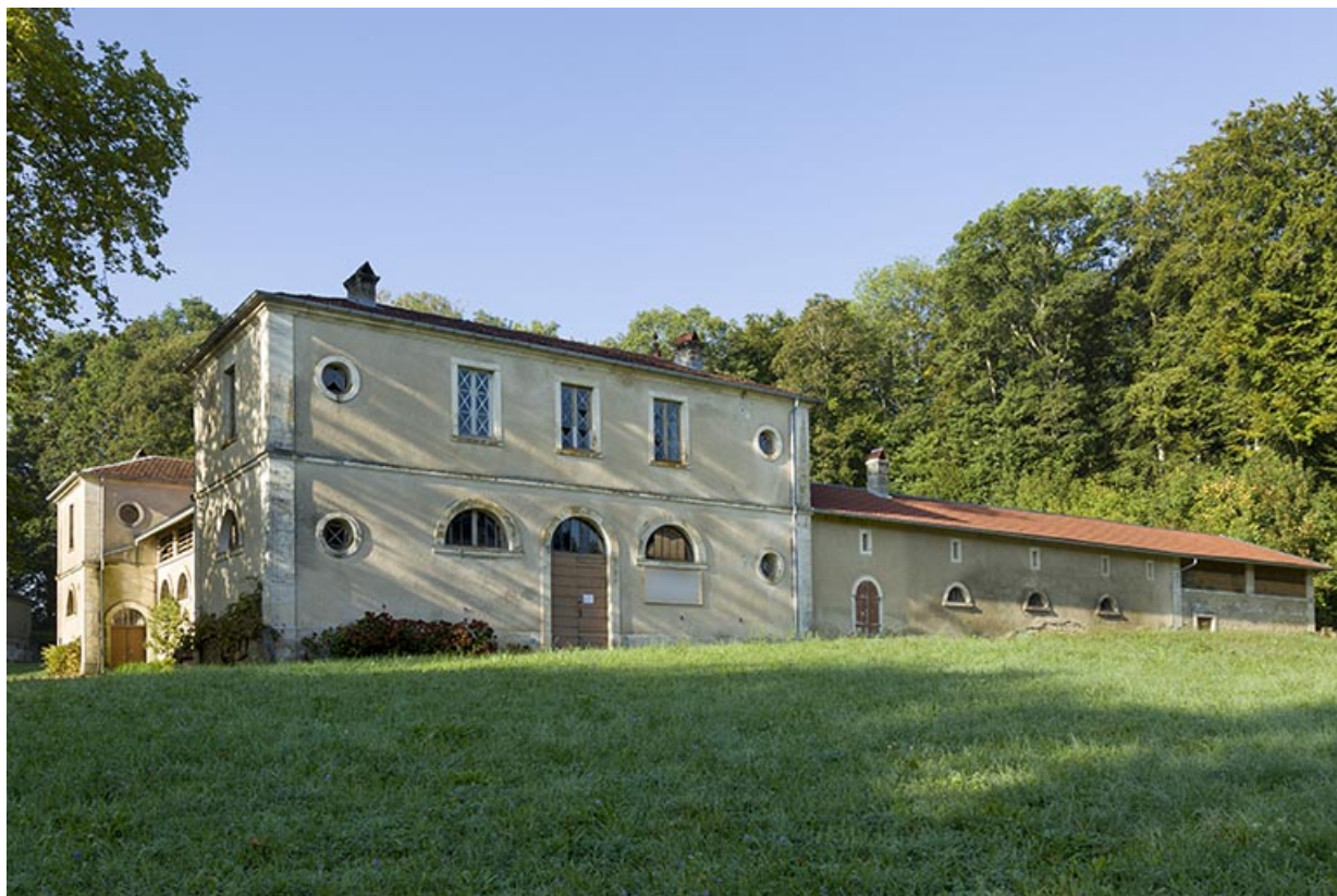
Ecurie : façade nord-est.
