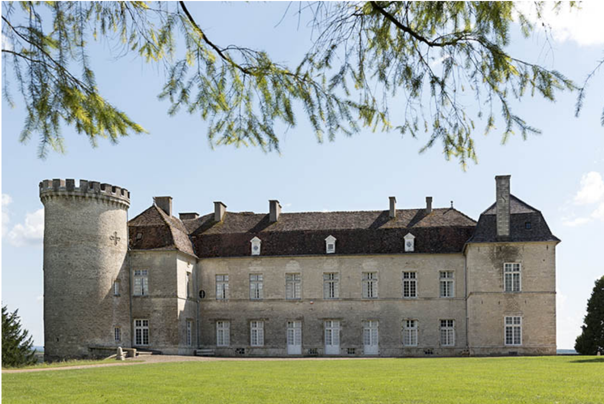
Vue générale de la façade nord.
