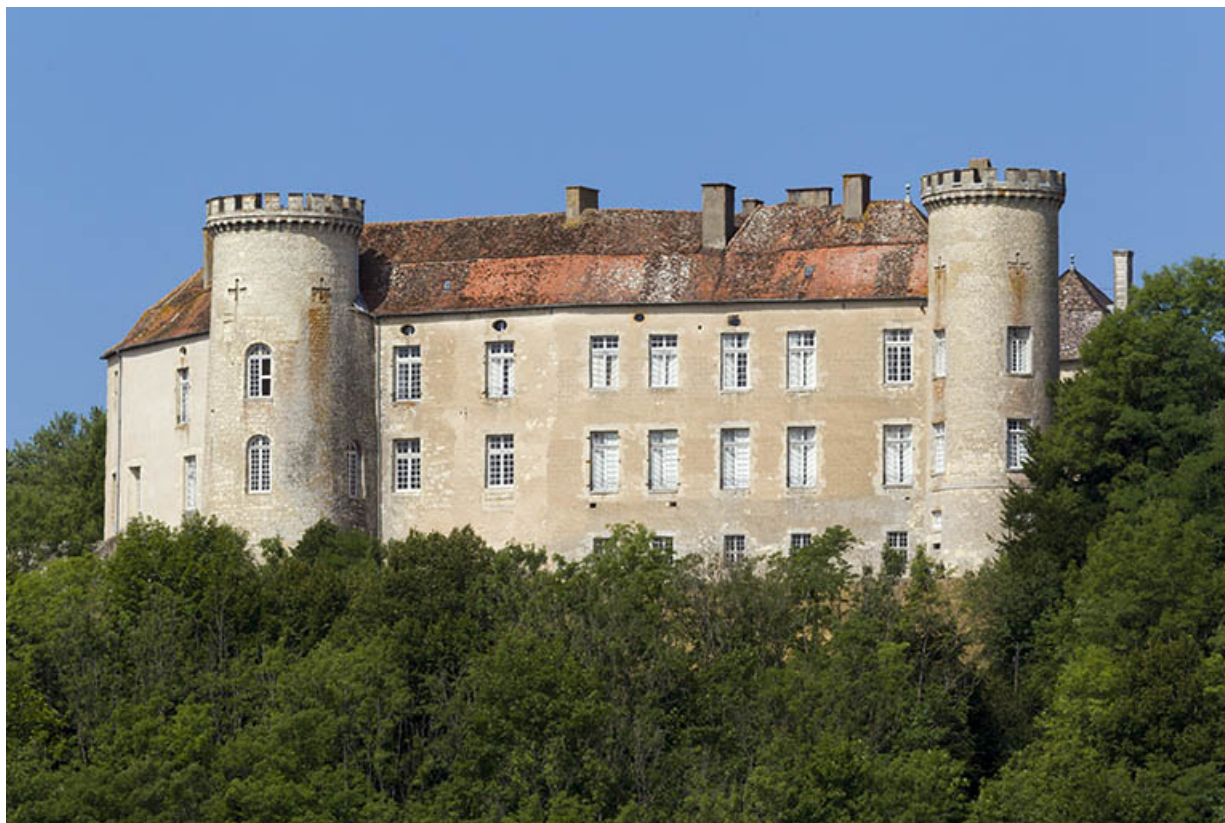
Vue générale de la façade est.
