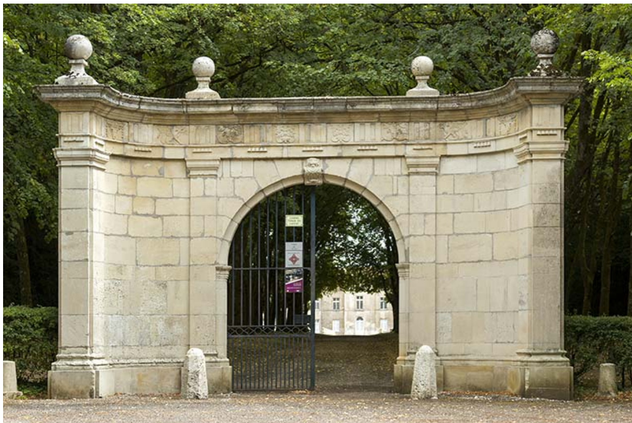
Portail à l'entrée du parc.
