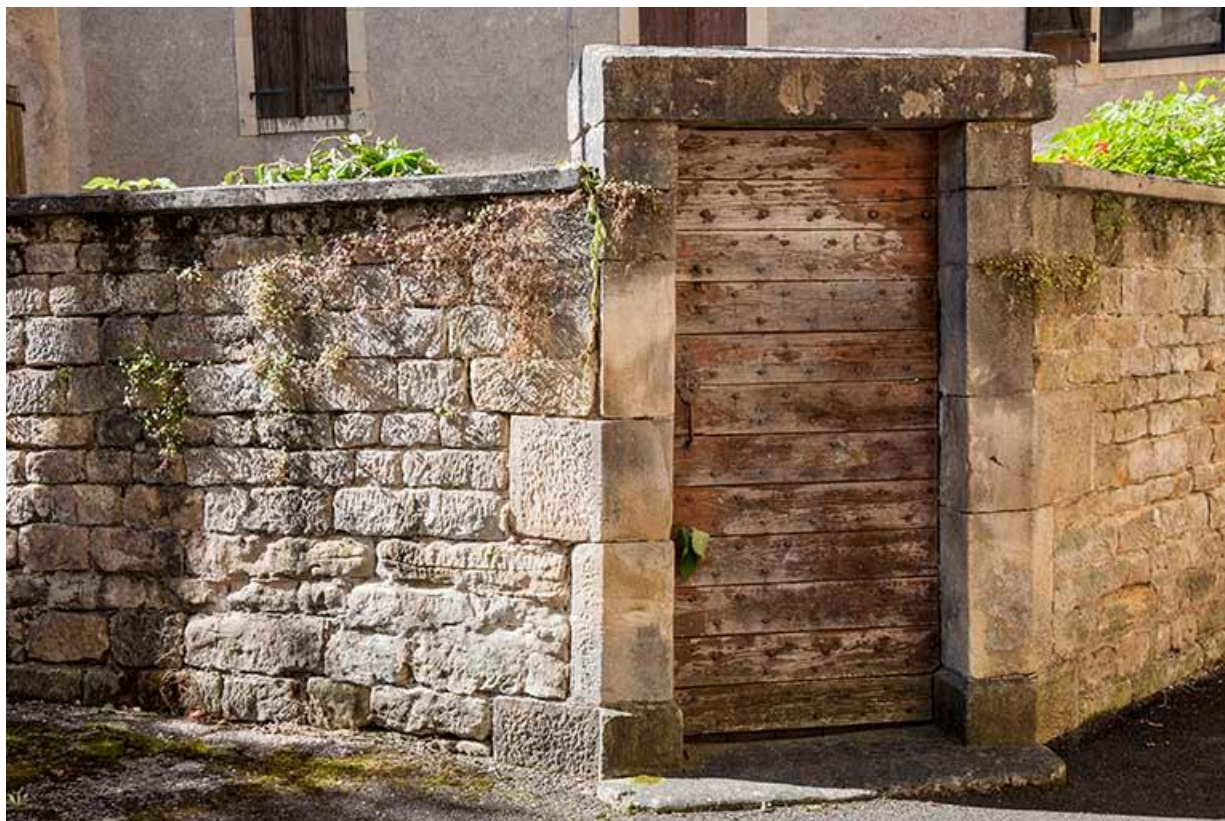
Le mur de clôture et l'accès au presbytère par le jardin arrière, en face de l'église. 70, Baulay rue de l'Église
