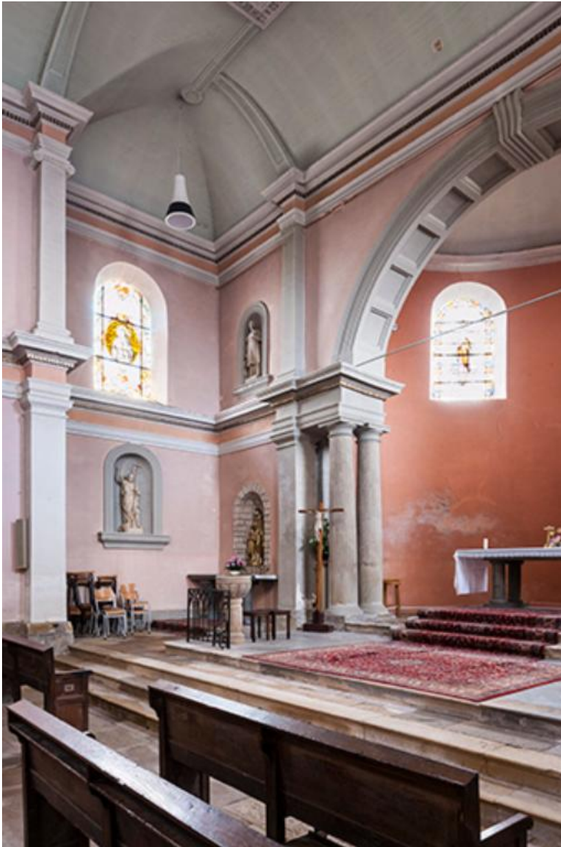
Jonction entre le mur collatéral Ouest et le chœur: retombée de voute sur deux colonnes doubles. 70, Baulay rue de l' Église
