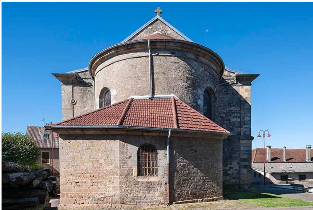
Le choeur et la sacristie de l'église, côté Nord. A droite, la façade Nord de l'école communale. 70, Baulay rue de l'Église
