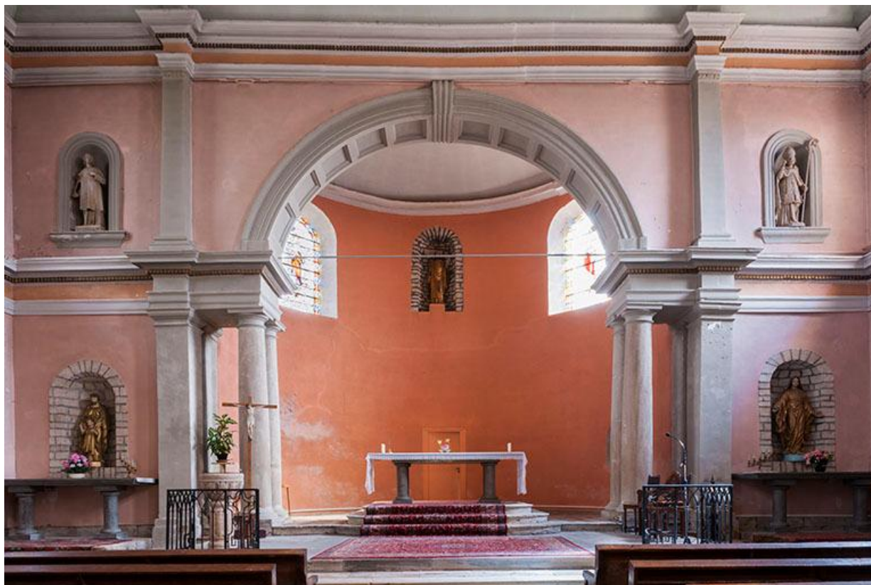
Choeur de l'église, arc en plein cintre retombant sur deux paires de colonnes doubles. 70, Baulay rue de l'Église
