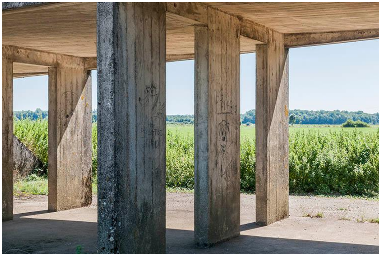
Les piles de béton du pont qui franchit la Saône entre Baulay et Fouchécourt. 70, Baulay
