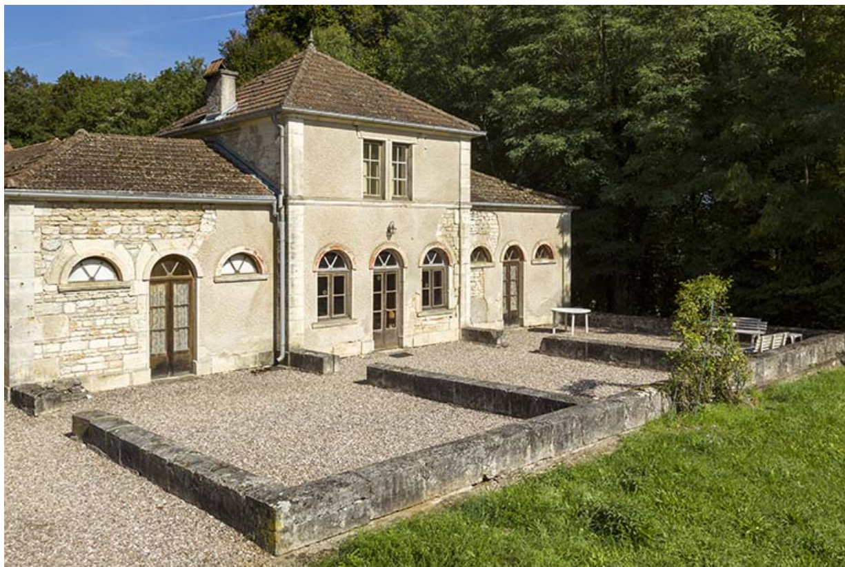
La façade antérieure, exposée au sud-est. 70, Rupt-sur-Saône, 5 rue de la Garenne
