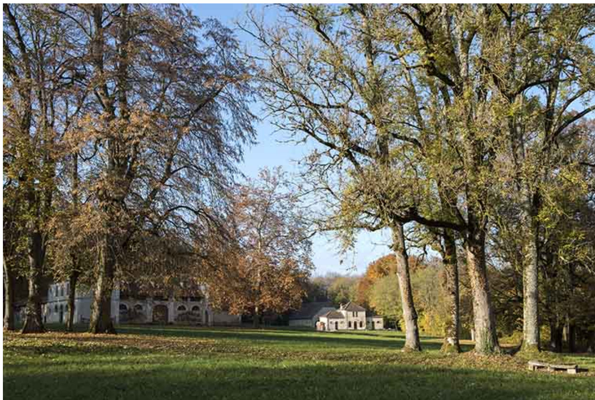
Vue générale avec la ferme (à gauche) et le chenil.
