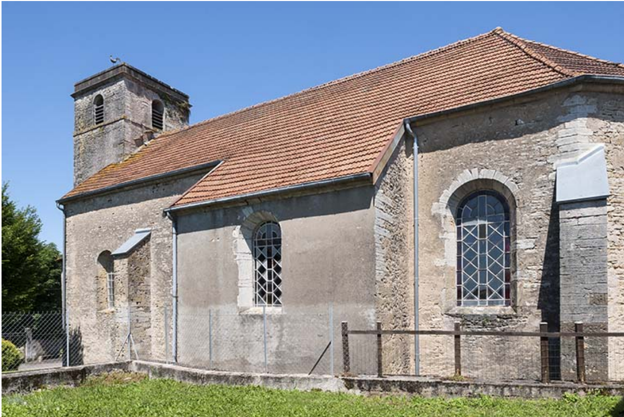
Vue latérale Sud 70, Chaux-lès-Port
