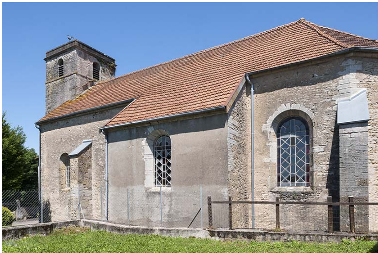
Vue latérale Sud 70, Chaux-lès-Port
