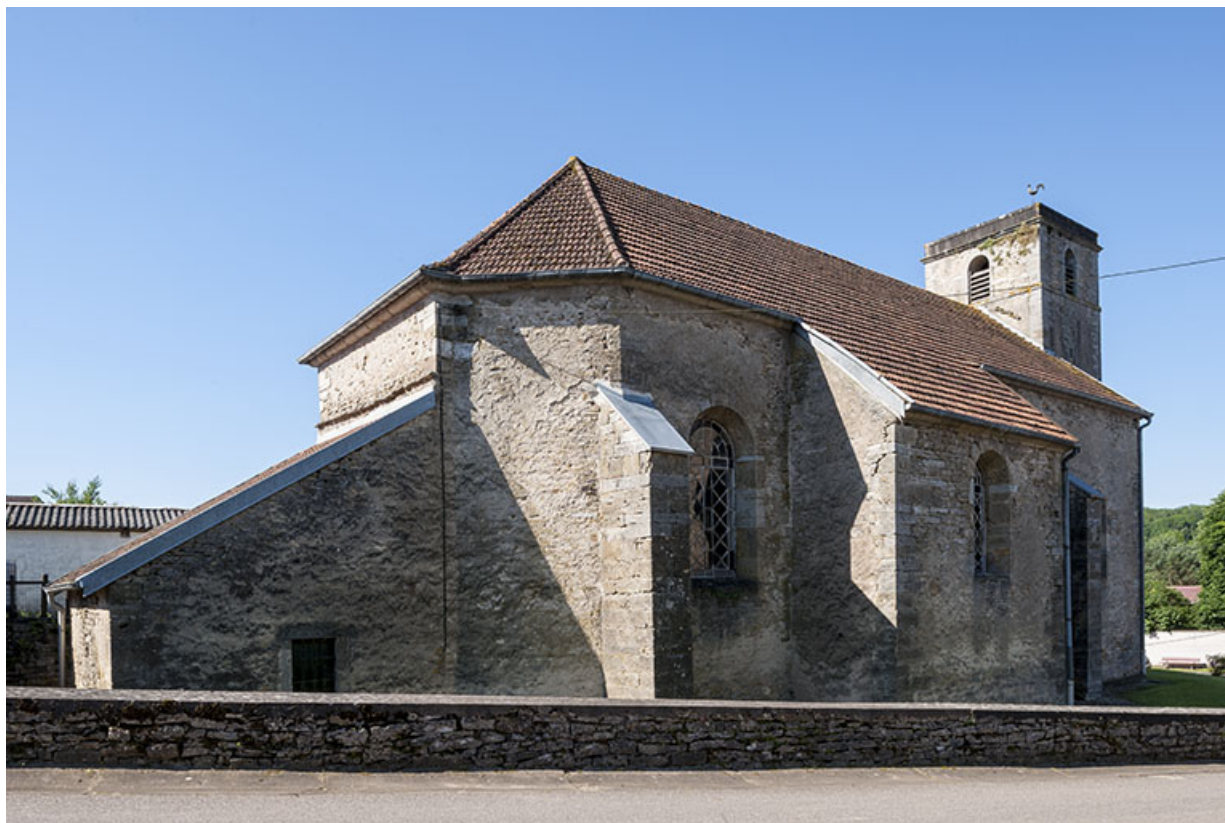
Vue latérale Nord, chevet et sacristie
