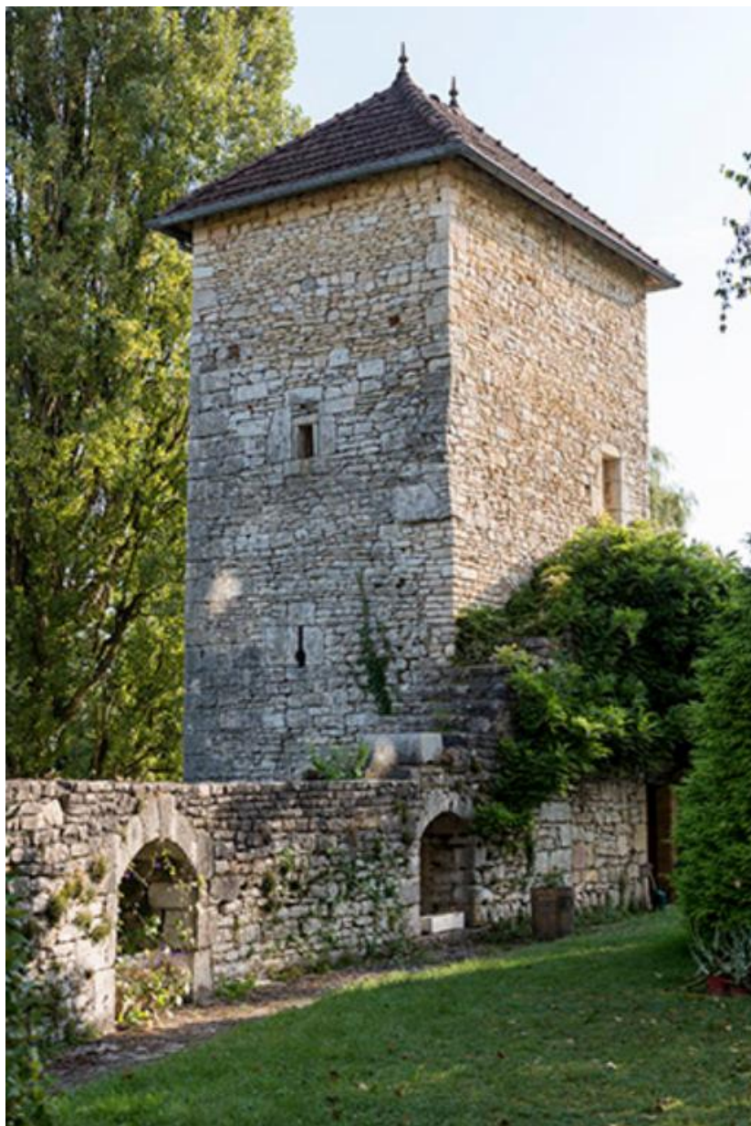
Tour le long du mur d'enceinte, vue depuis la basse-cour
