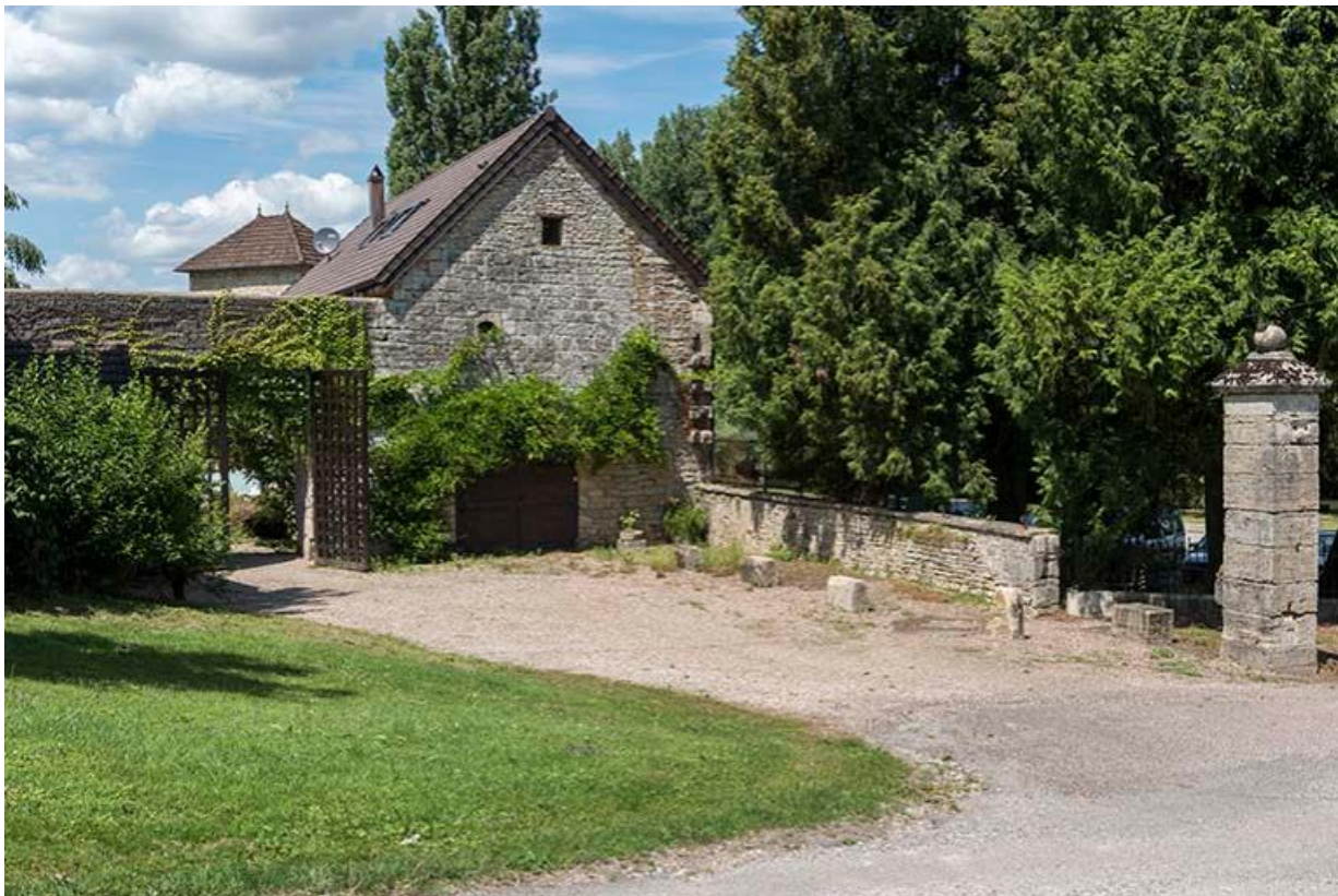
Vue de l'entrée dans la basse-cour et accès aux anciens communs du château 70, Chemilly, lieudit : La Côte
