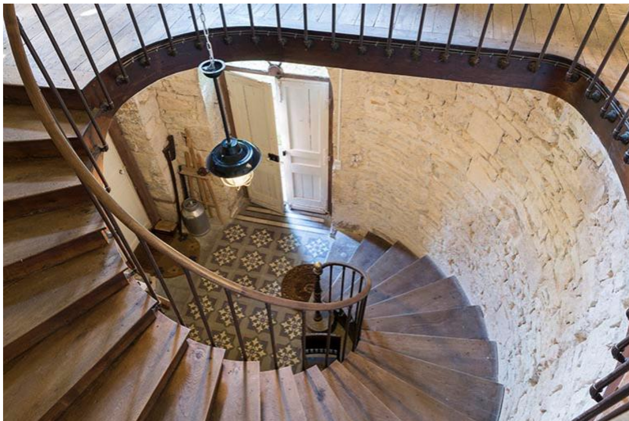
Escalier au rez-de-chaussée du logis central du château.
