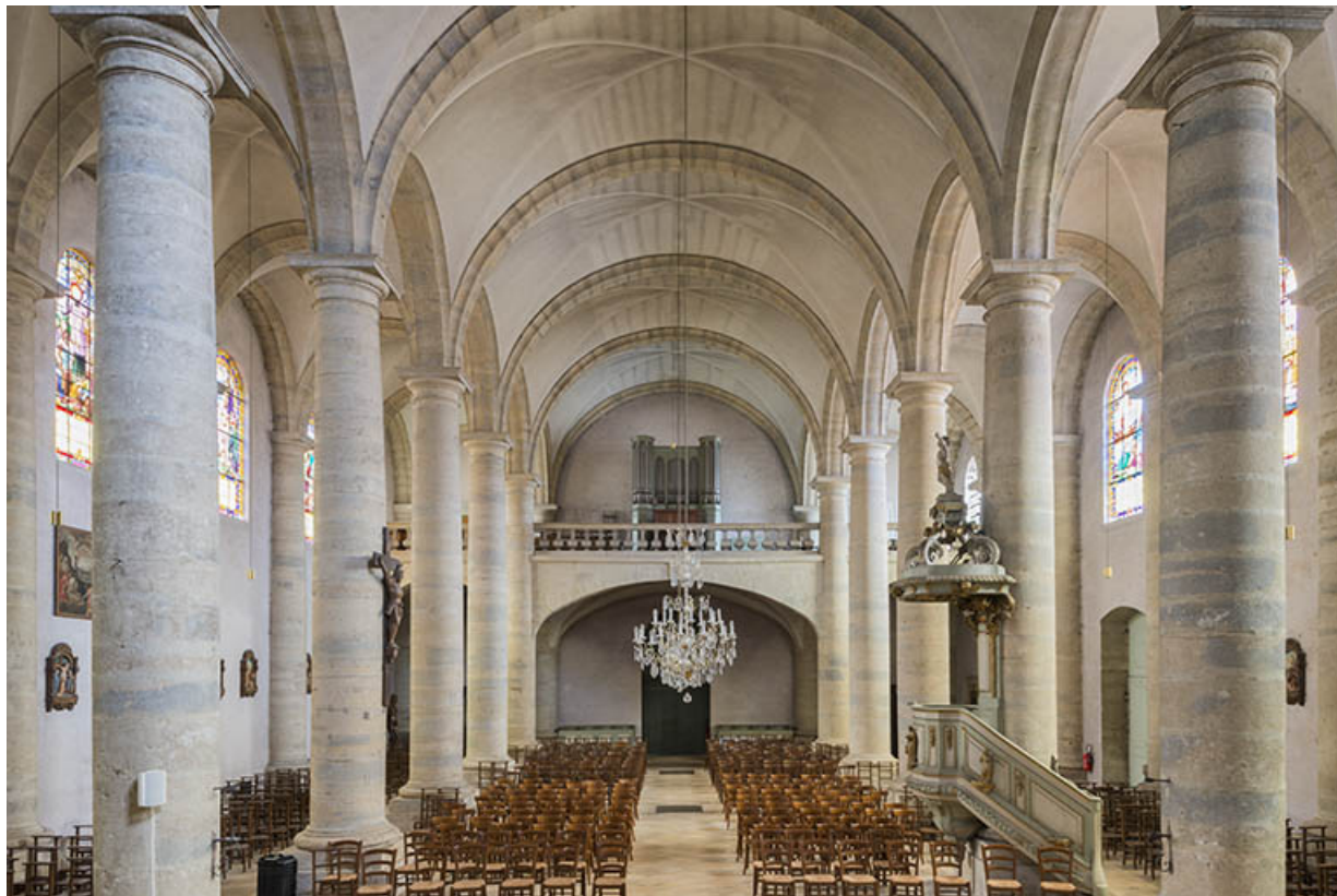
Vue générale de l'église de type halle.
