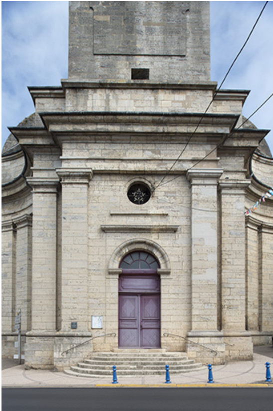
La façade principale et le portail d'entrée.
