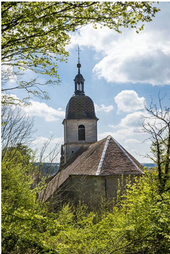
Vue depuis l'ancien cimetière. 70, Port-sur-Saône Grande Rue
