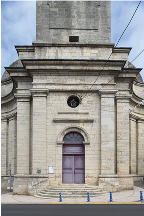
La façade principale et le portail d'entrée.
