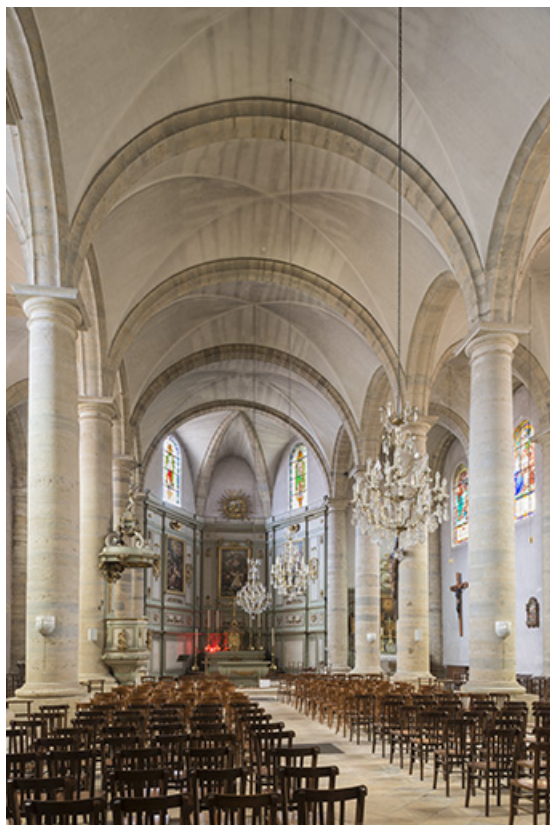
Vue générale de la nef centrale.
