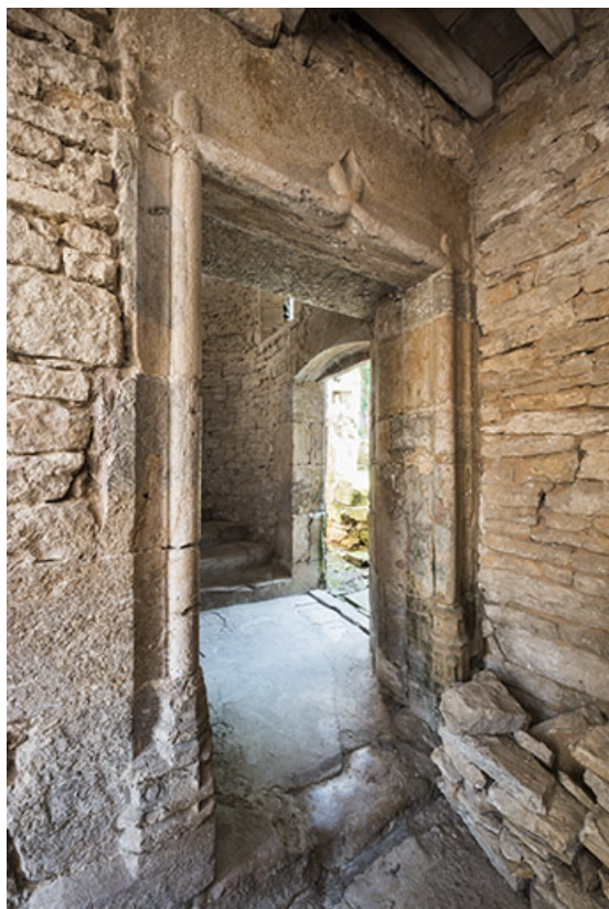
Porte d'accès vers l'escalier de l'ancien prieuré. 70, Port-sur-Saône
