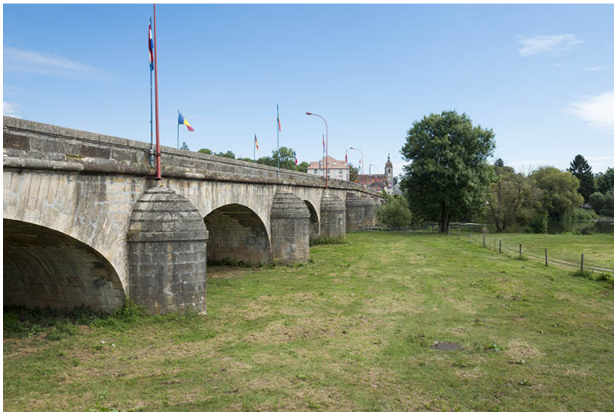
Le pont en pierre. 70, Port-sur-Saône
