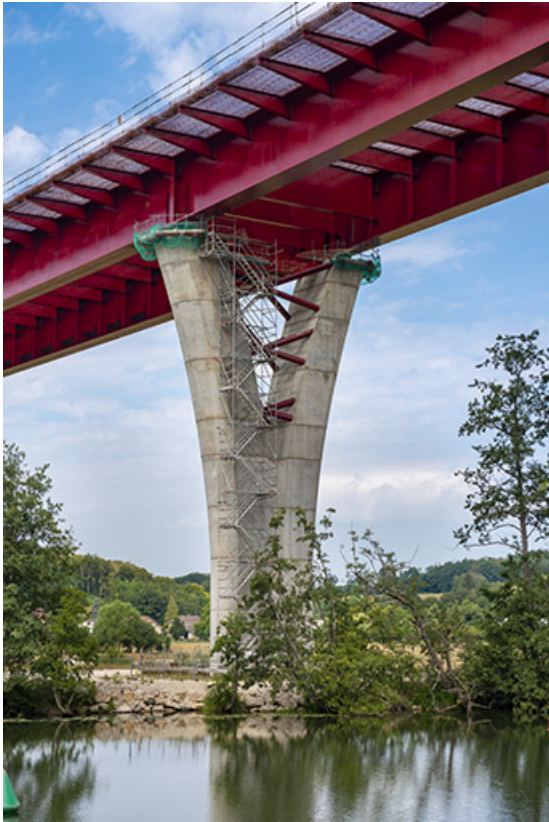
Le viaduc de la déviation de Port-sur-Saône en construction. 70, Port-sur-Saône
