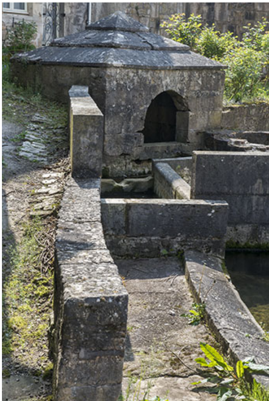
Le lavoir, rue de la Fontaine. 70, Port-sur-Saône
