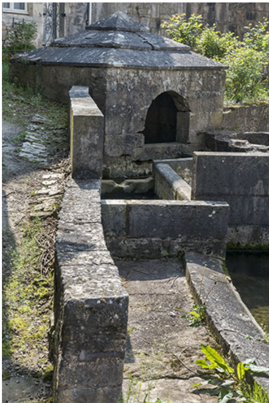
Le lavoir, rue de la Fontaine. 70, Port-sur-Saône
