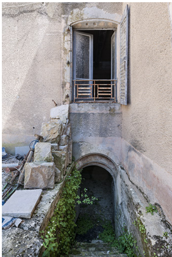
Escalier dans la cour d'accès à la cave.
