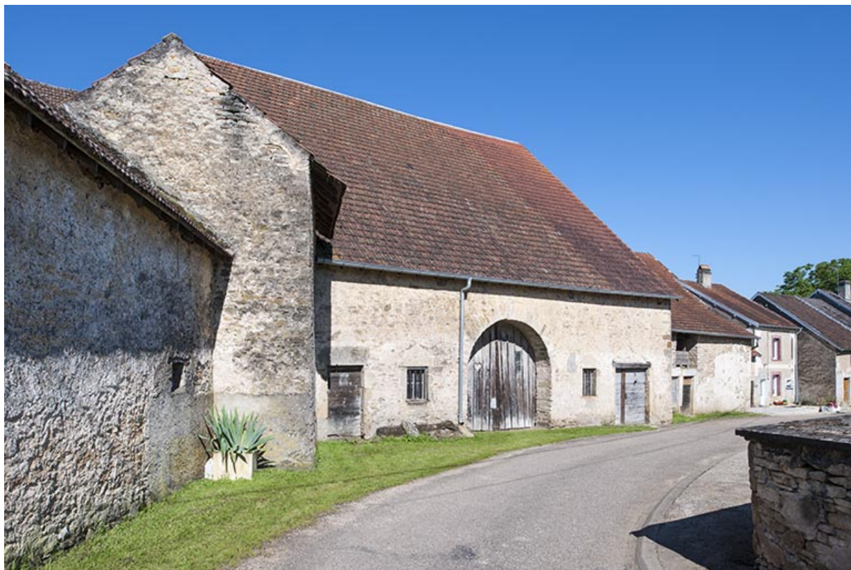
Ferme, chemin de la Saône. 70, Chaux-lès-Port
