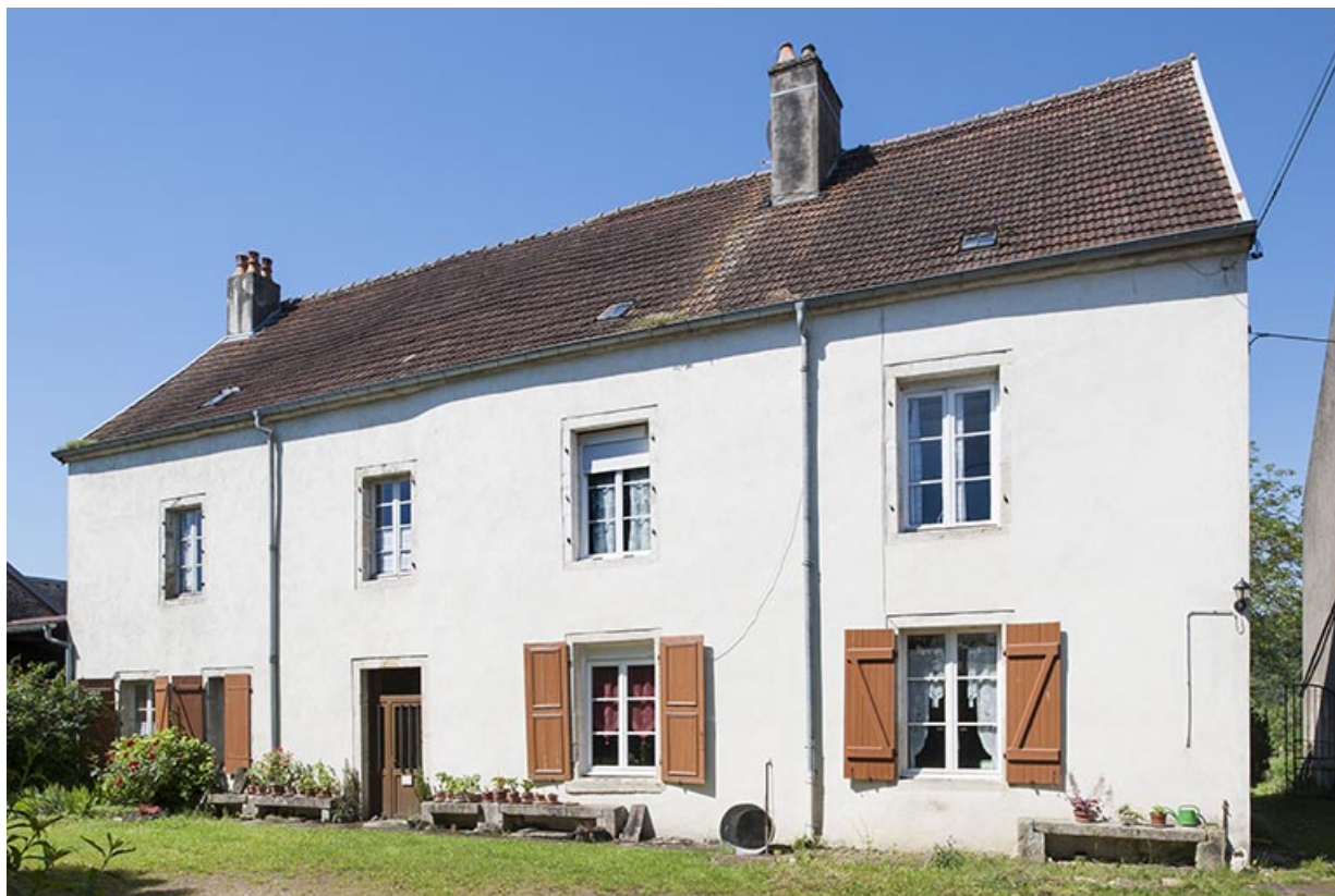
Château du village. 70, Chaux-lès-Port
