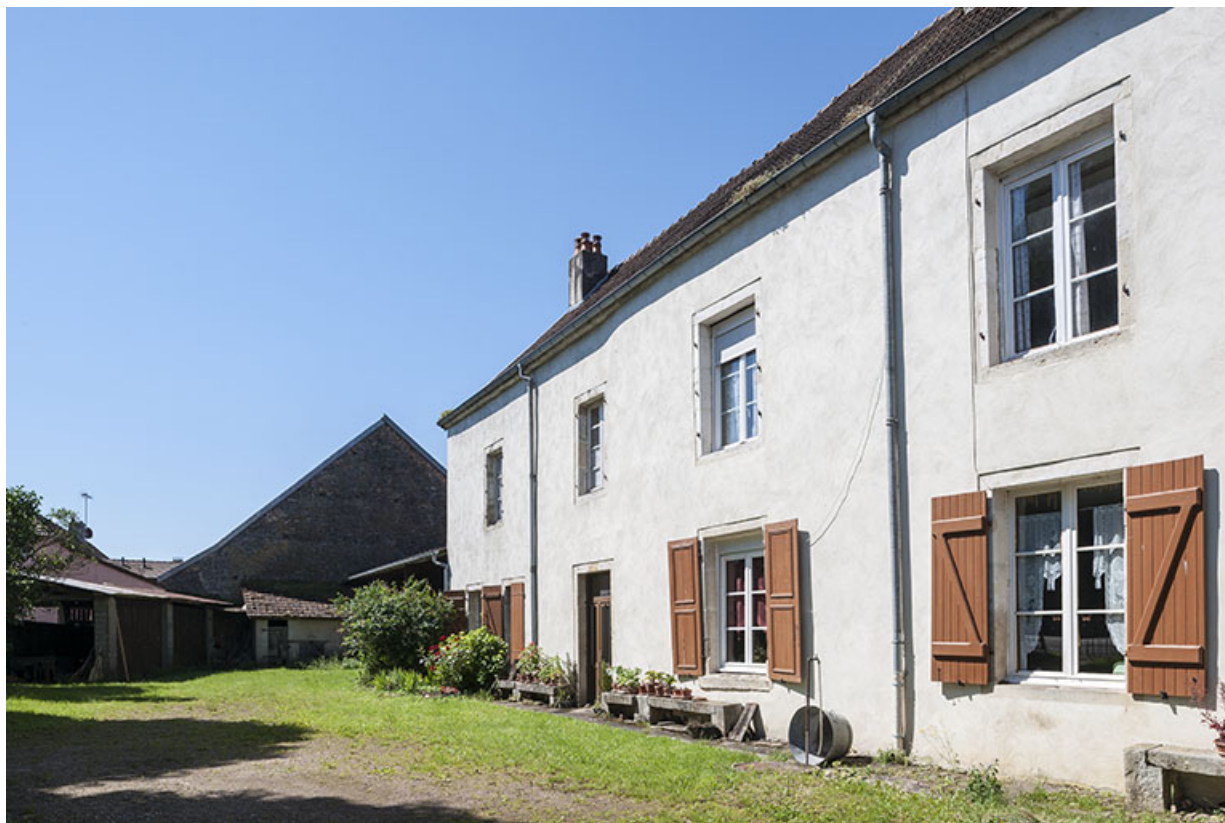
Château du village. 70, Chaux-lès-Port
