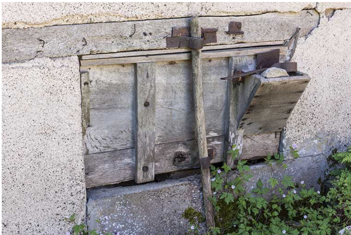
Détail de la soue. 70, Chaux-lès-Port
