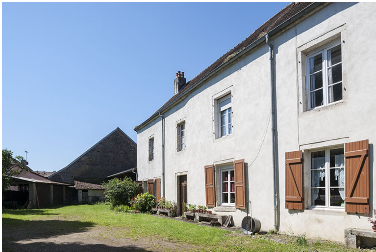
Château du village. 70, Chaux-lès-Port
