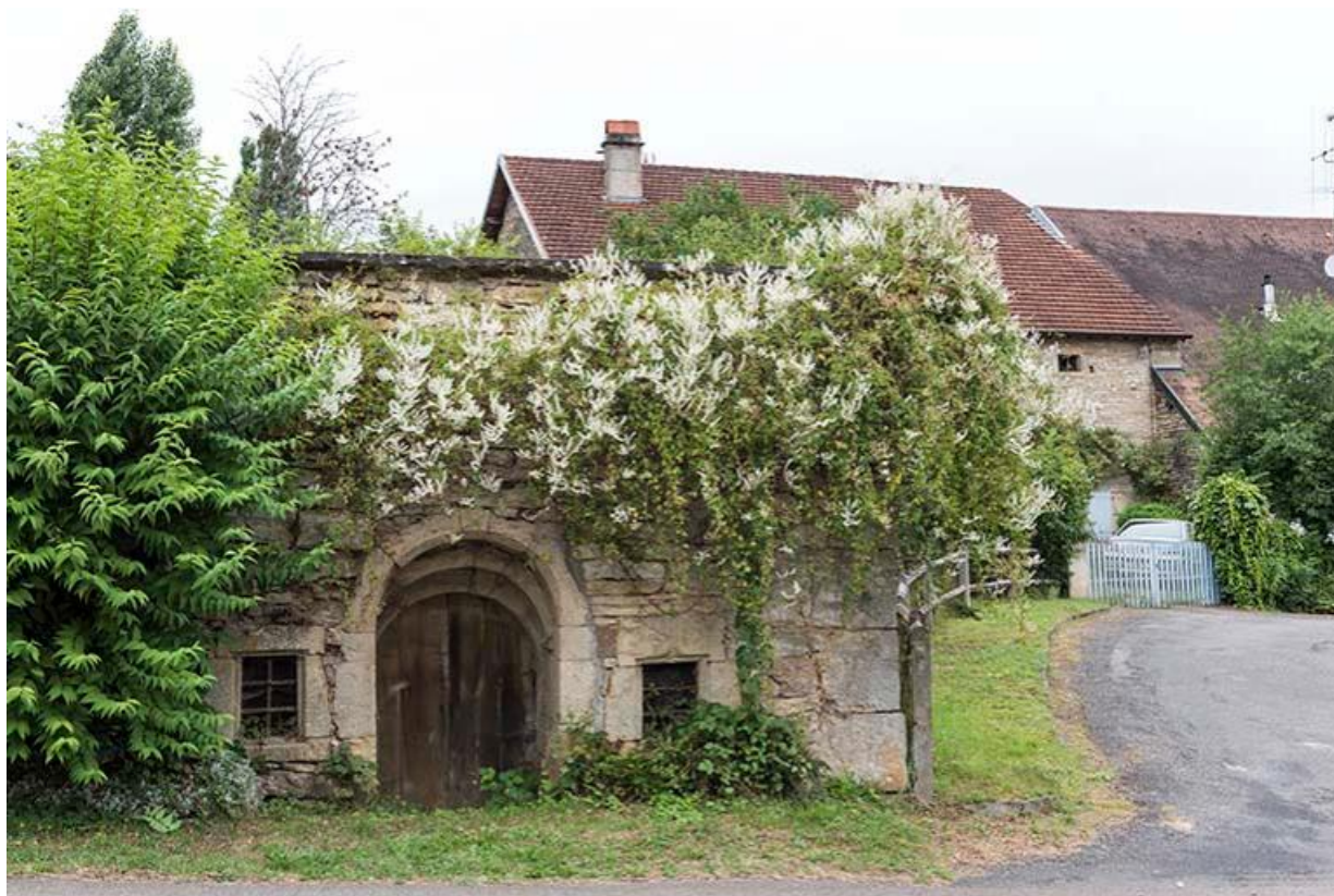
Entrée de cave de la maison dite "espagnole", depuis la Grande rue 70, Chemilly, 6 rue de la Petite Rampe
