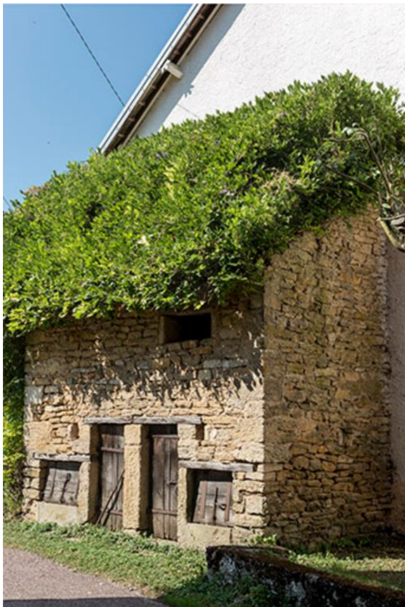
Soue à cochons située rue de la Barque
