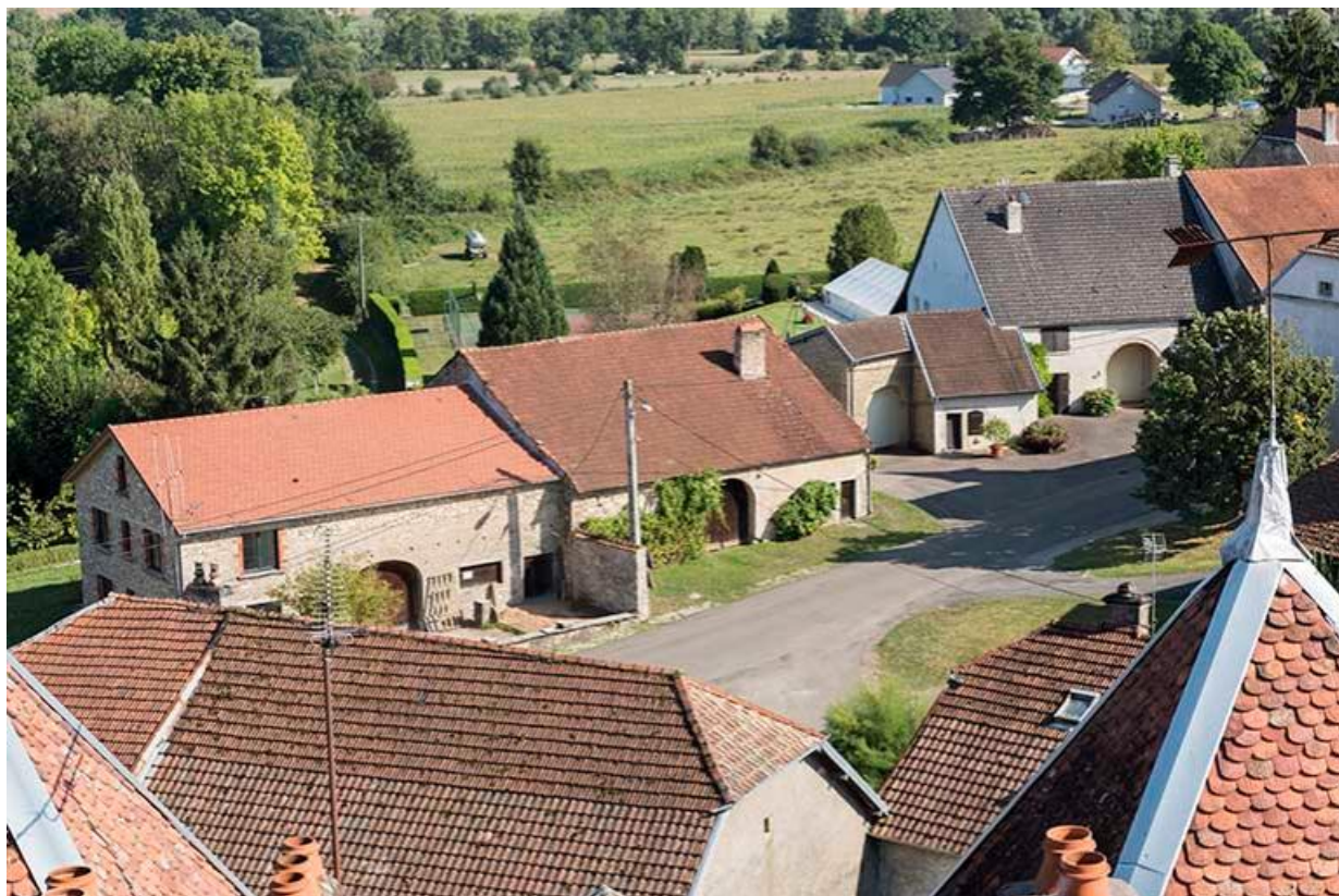
Vue des fermes alignées le long de la rue Grande, depuis le toit-terrasse du donjon du château. 70, Chemilly, 6 rue de la Petite Rampe
