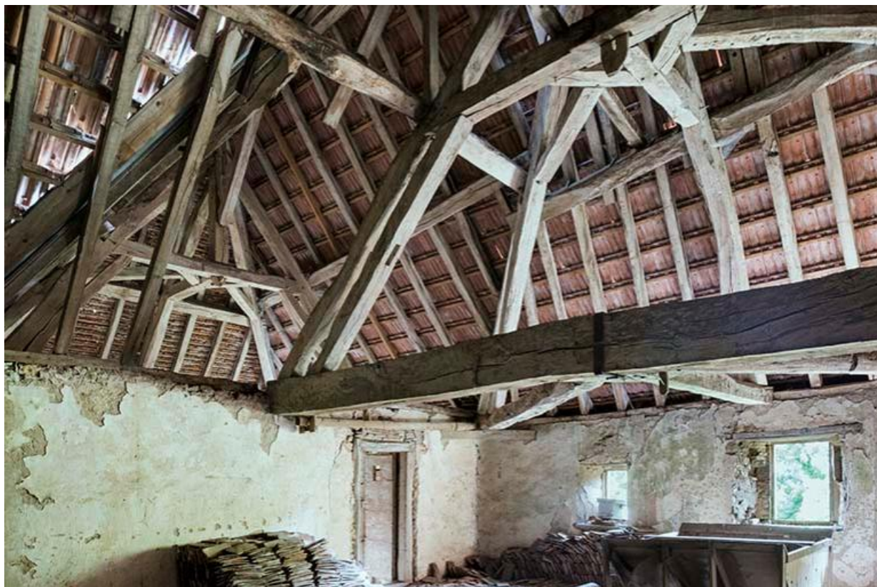
Vue de la charpente du grenier de la chapelle 70, Chemilly
