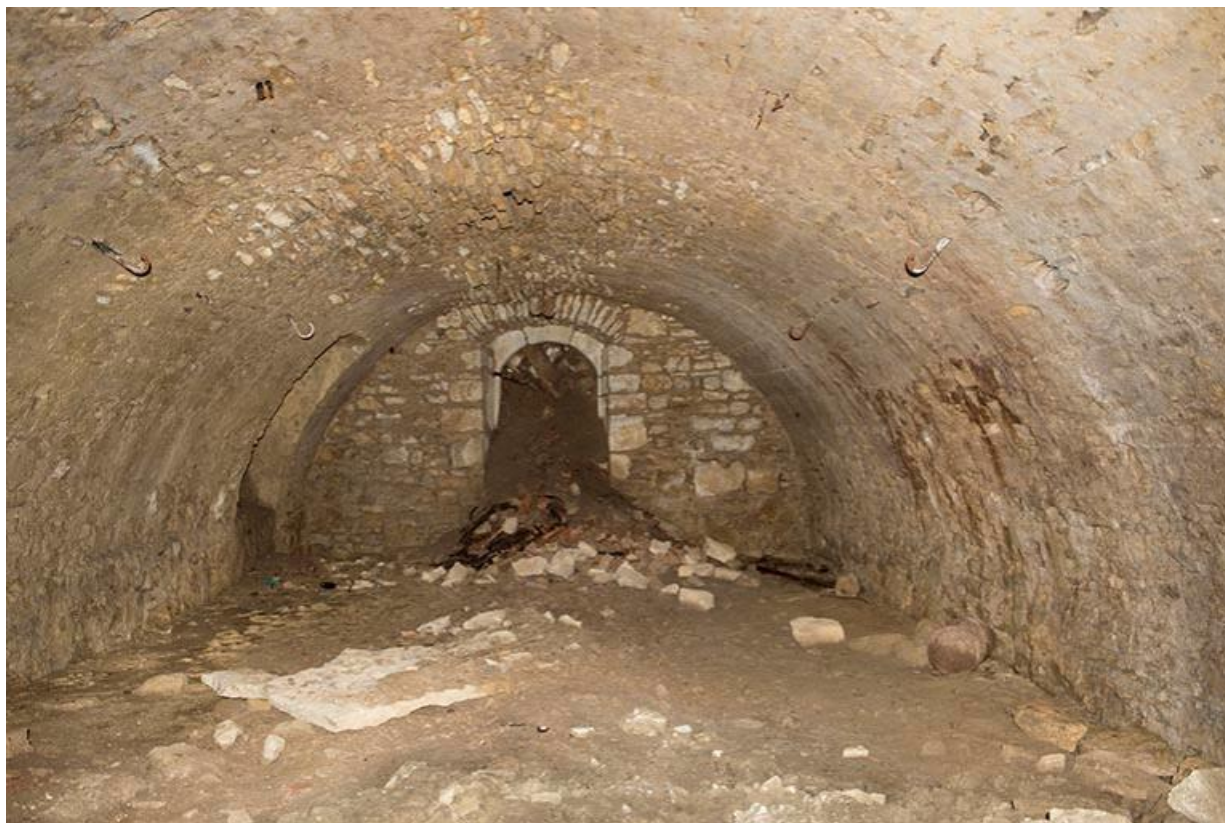
Cave située sous l'aile du logis conventuel aujourd'hui détruit 70, Chemilly
