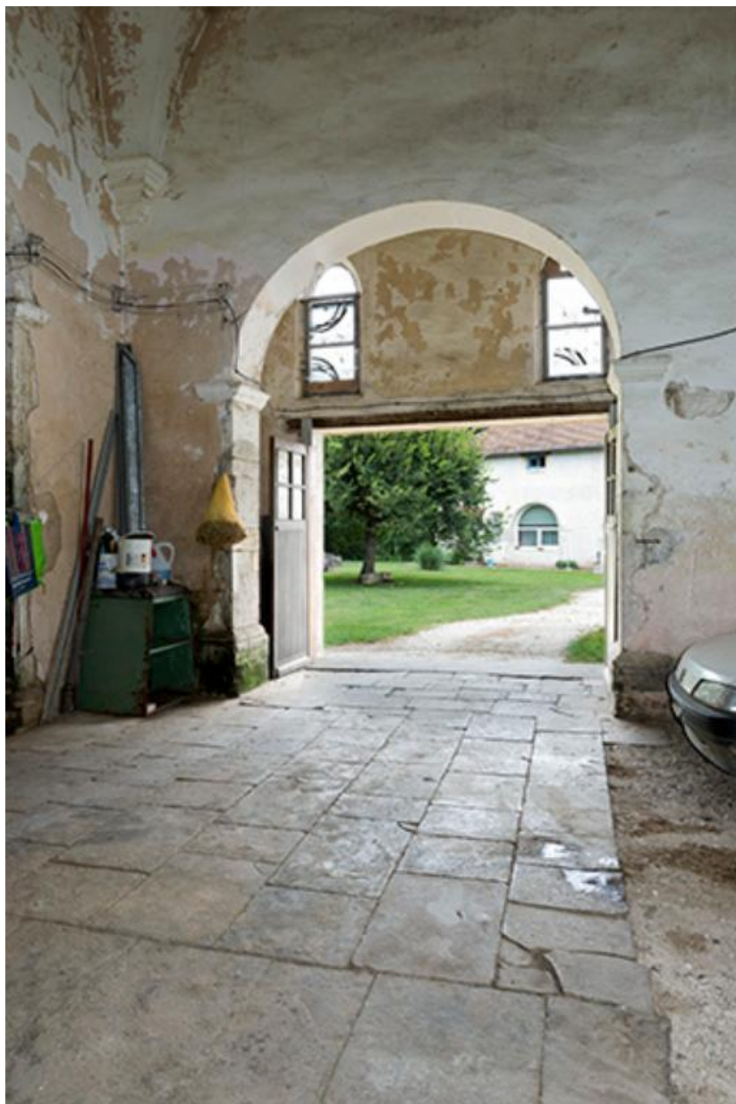
Vue de l'entrée donnant sur la cour 70, Chemilly
