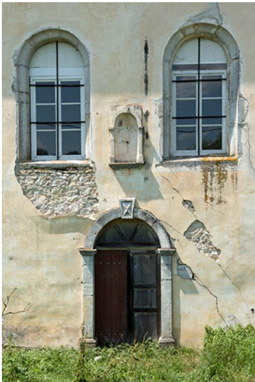
Façade principale de la chapelle
