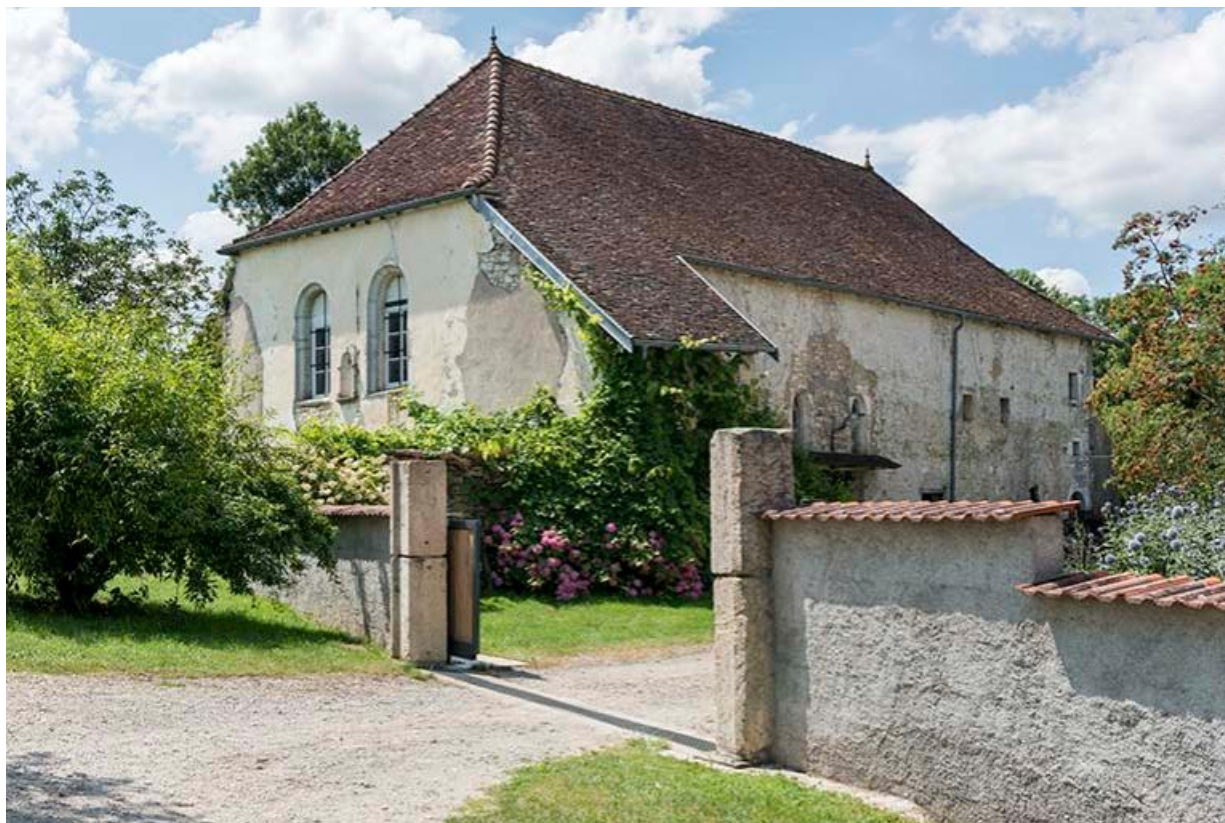
Vue de la chapelle, côté cour 70, Chemilly
