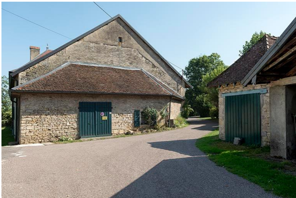
Vue de la ferme côté Ouest, le four à pain contre le mur pignon et la soue à cochons sur la droite. 70, Chemilly, 3 rue de la Barque
