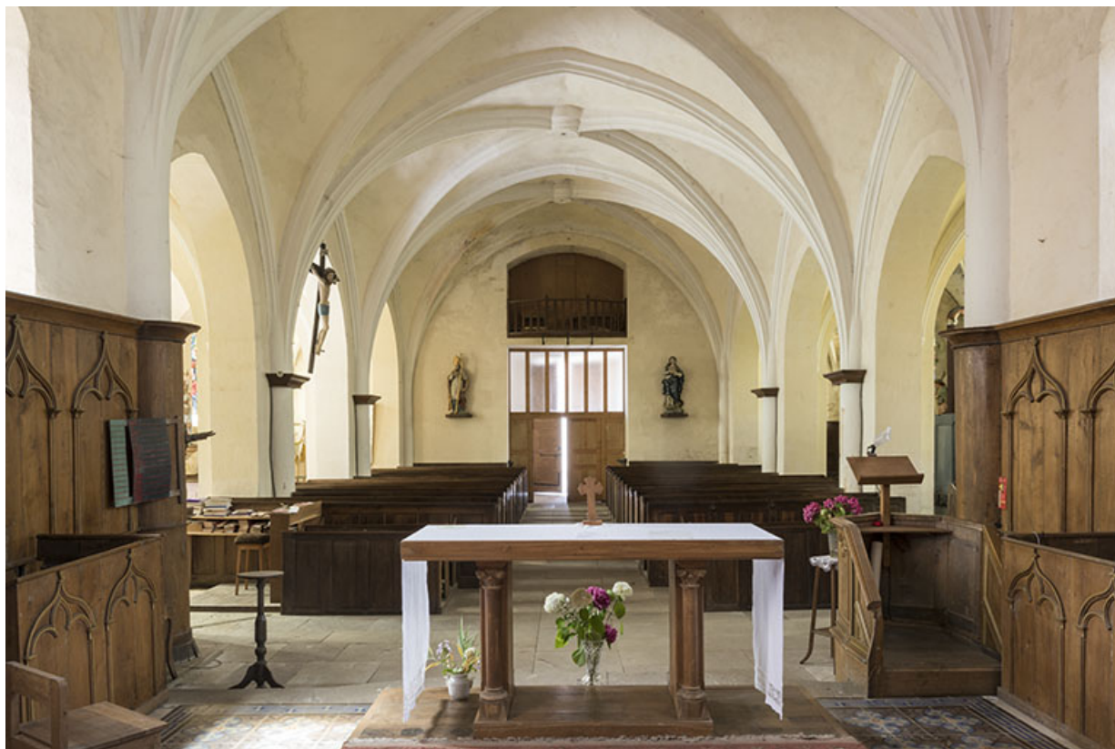
Vue intérieure de la nef depuis le chœur.
