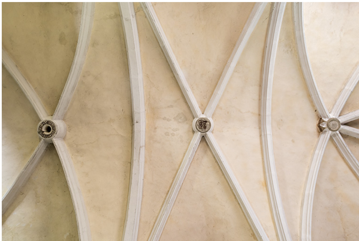
Vue de détail de la voûte en ogive et clés sculptées.
