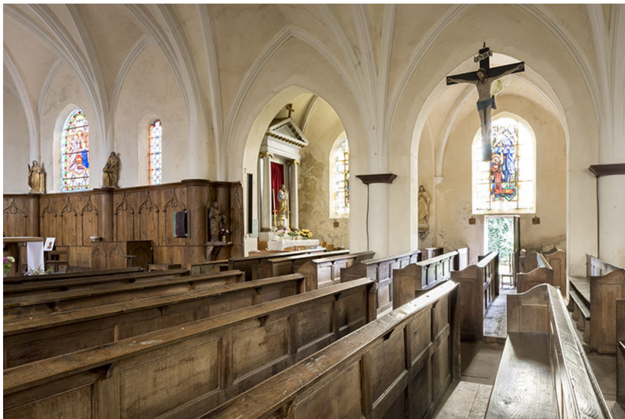
Vue intérieure de trois-quart du collatéral sud.
