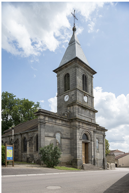
Vue de trois-quart nord.
