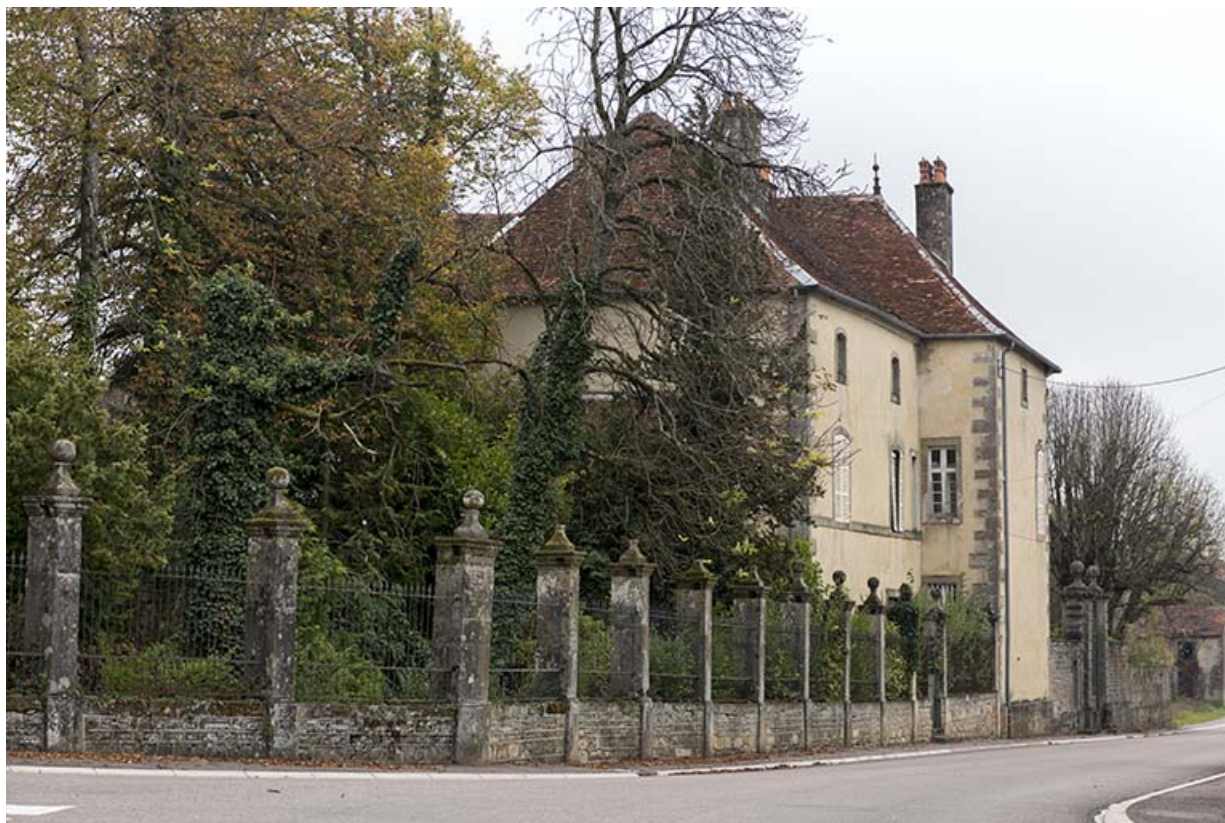
La façade sur rue et le parc vus du nord-ouest.
