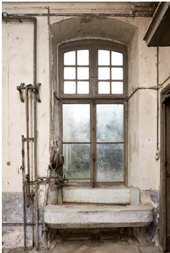
Rez de chaussée, cuisine, pierre d'évier.
