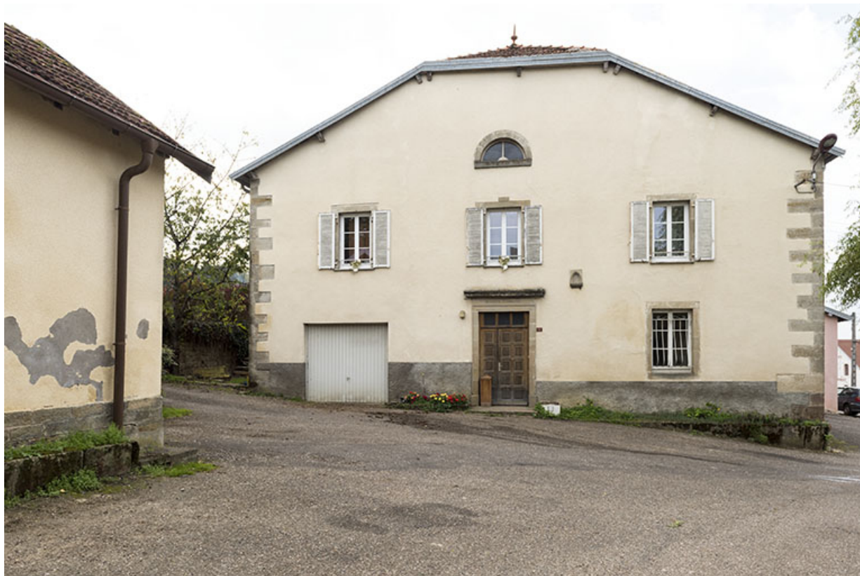
Vue de face : pignon est.
