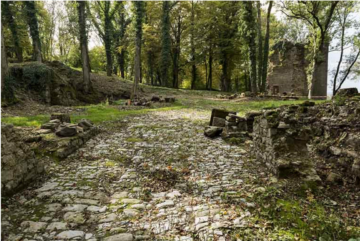
Chemin d'accès et vue sur la tour ouest. 70, Demangevelle
