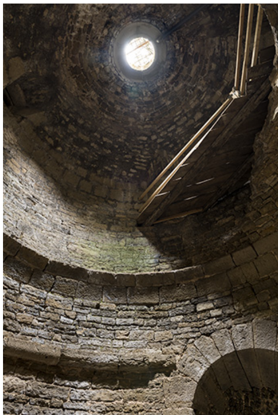
Dans la tour ouest. Vue de la partie sommitale depuis l'intérieur. 70, Demangevelle
