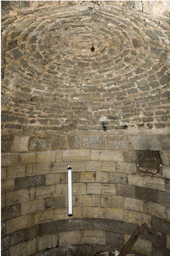
Dans la tour ouest. Niveau inférieur : citerne? 70, Demangevelle
