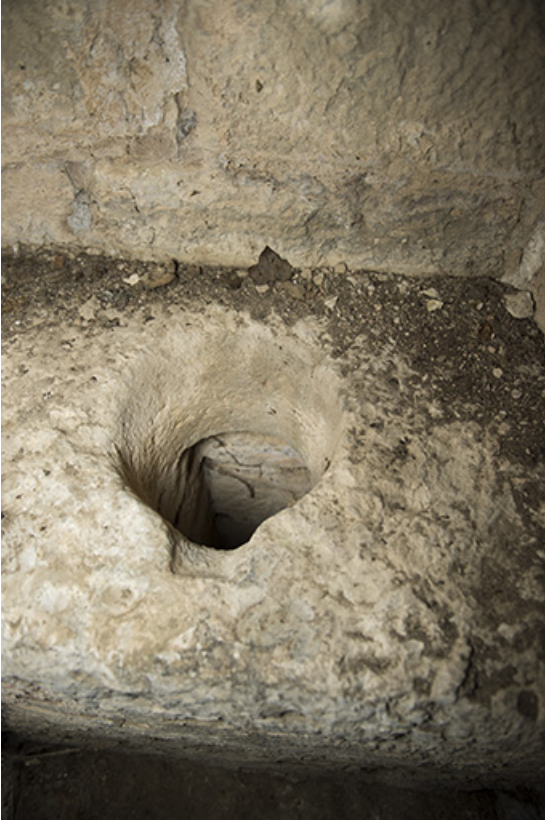
Dans la tour ouest. Détail de latrines.
