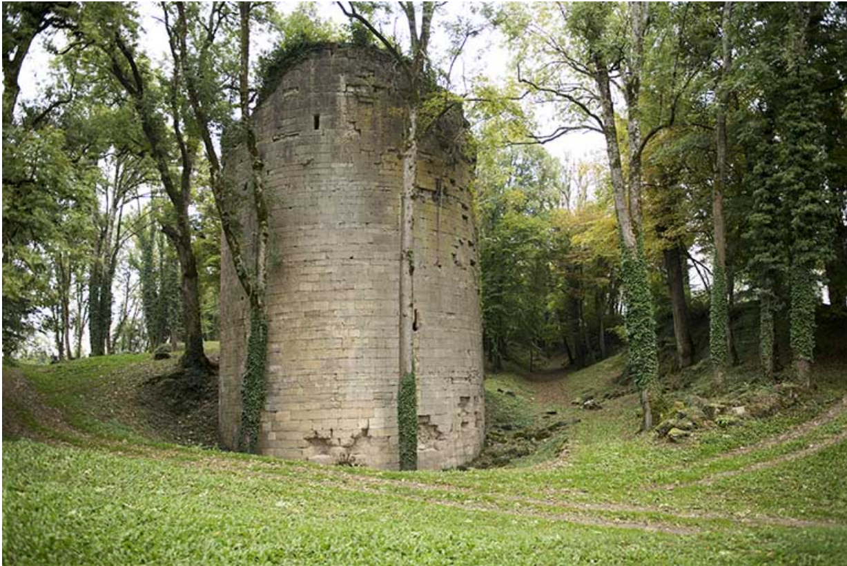
La tour ouest, vue de l'ouest.
