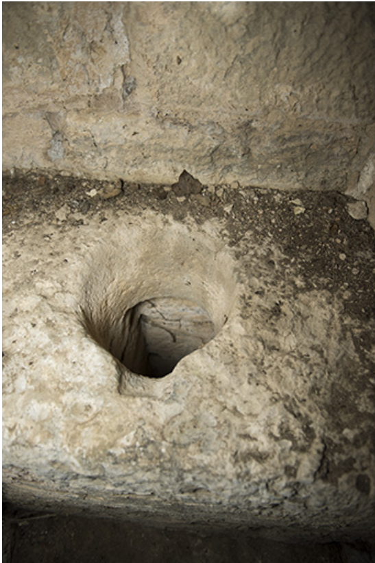
Dans la tour ouest. Détail de latrines.
