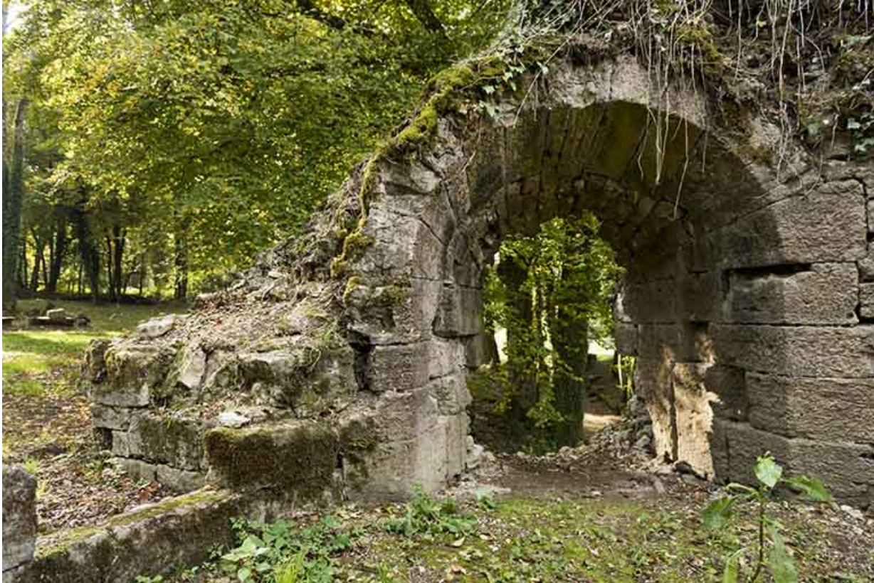
Tour est. Meurtrière orientée vers le sud ouest. 70, Demangevelle
