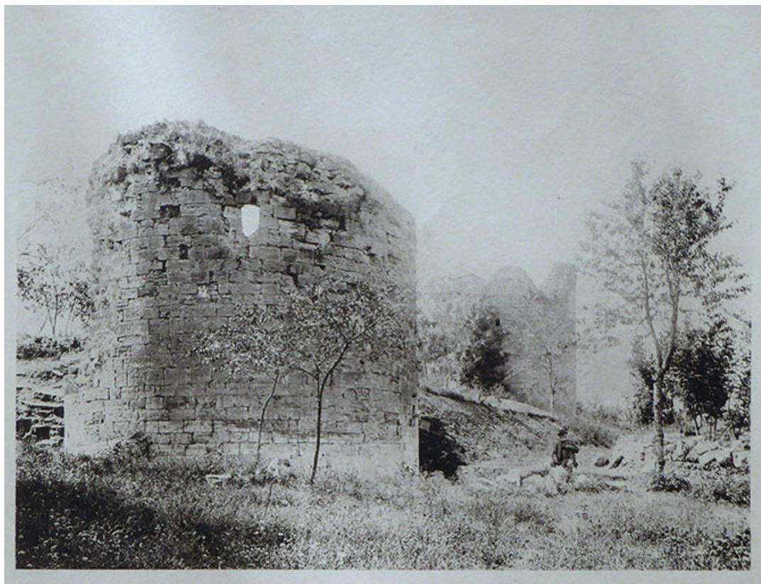
Photographie de Vedastus : les ruines de Demangevelle. Août 1890. 70, Demangevelle
