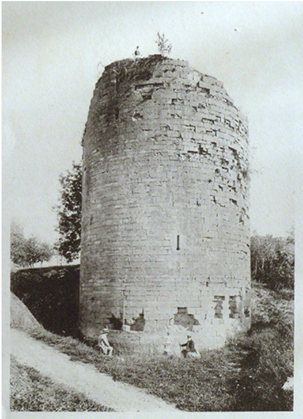
Photographie de Vedastus : les ruines de Demangevelle. Août 1890. 70, Demangevelle
