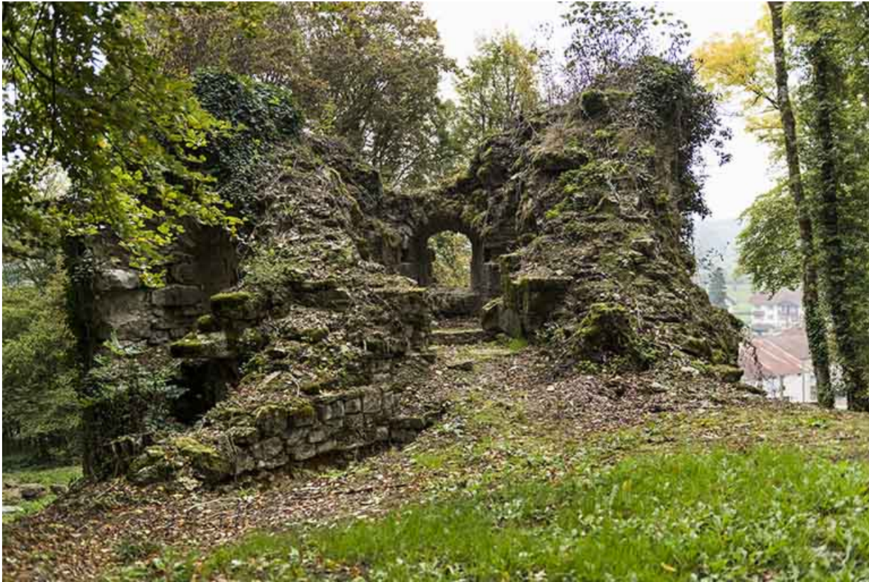
Vue sur la tour est. 70, Demangevelle
