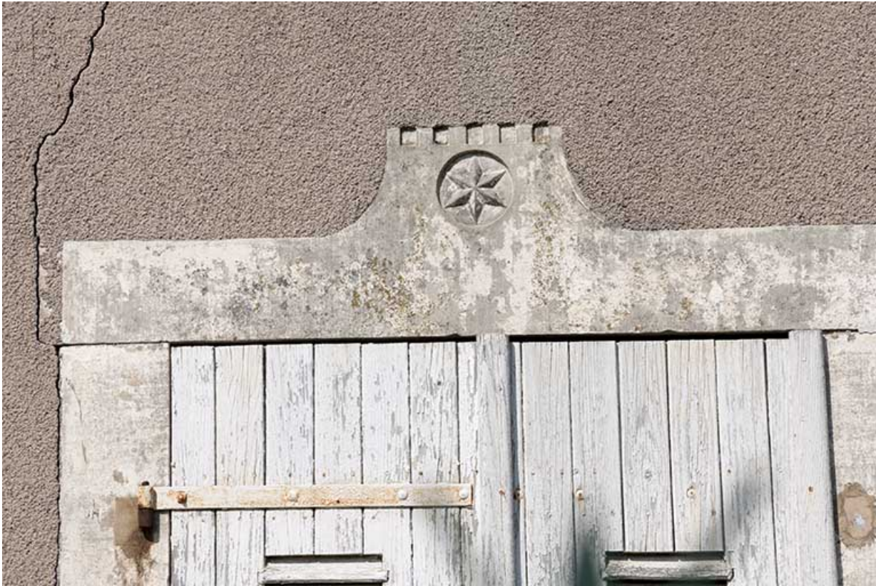
Détail du décor sur les linteaux.
