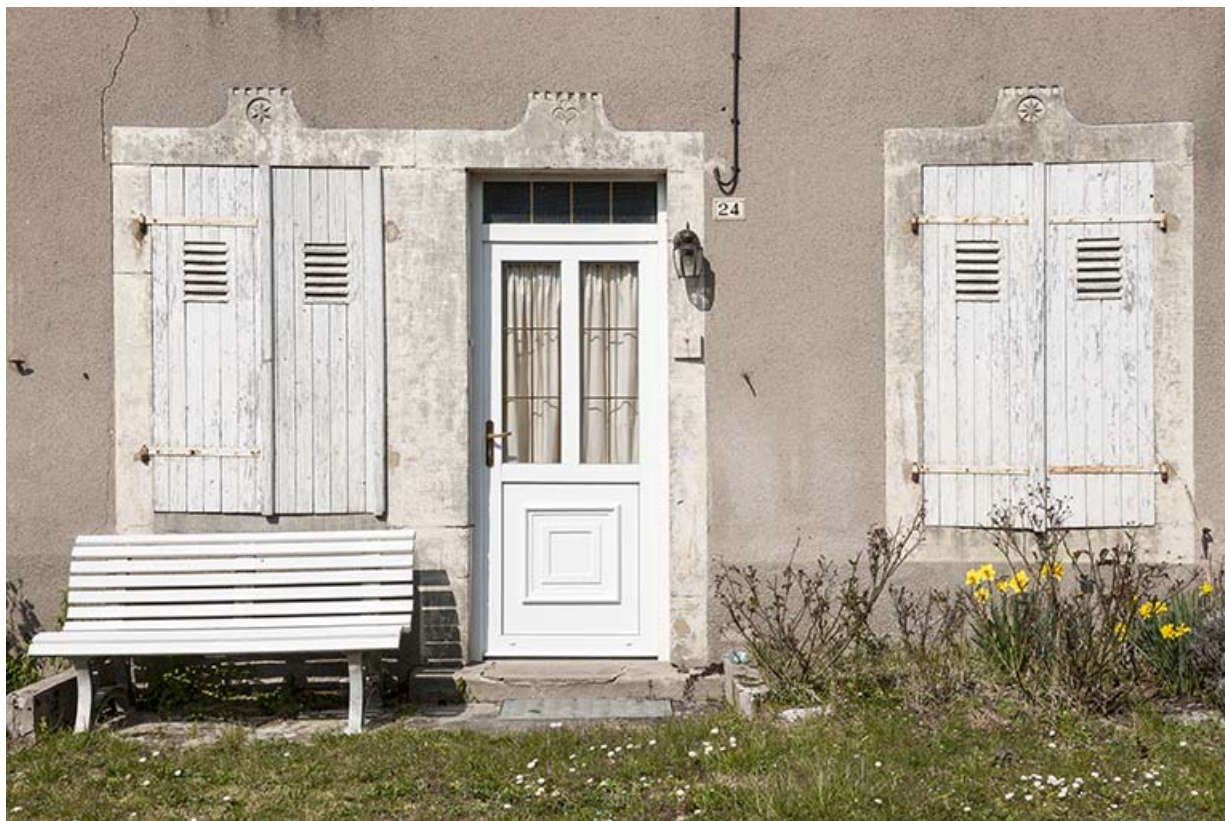
Porte d'entrée, façade principale.
