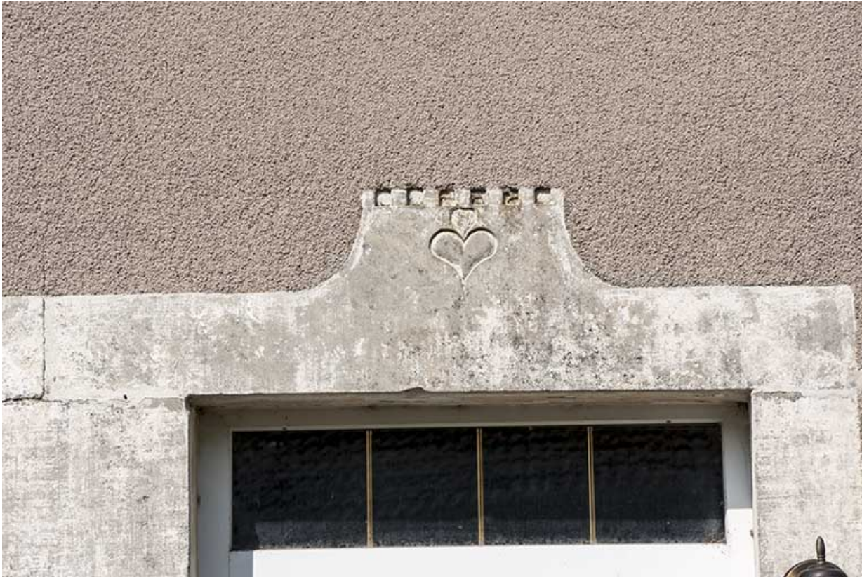
Détail du décor sur les linteaux.
