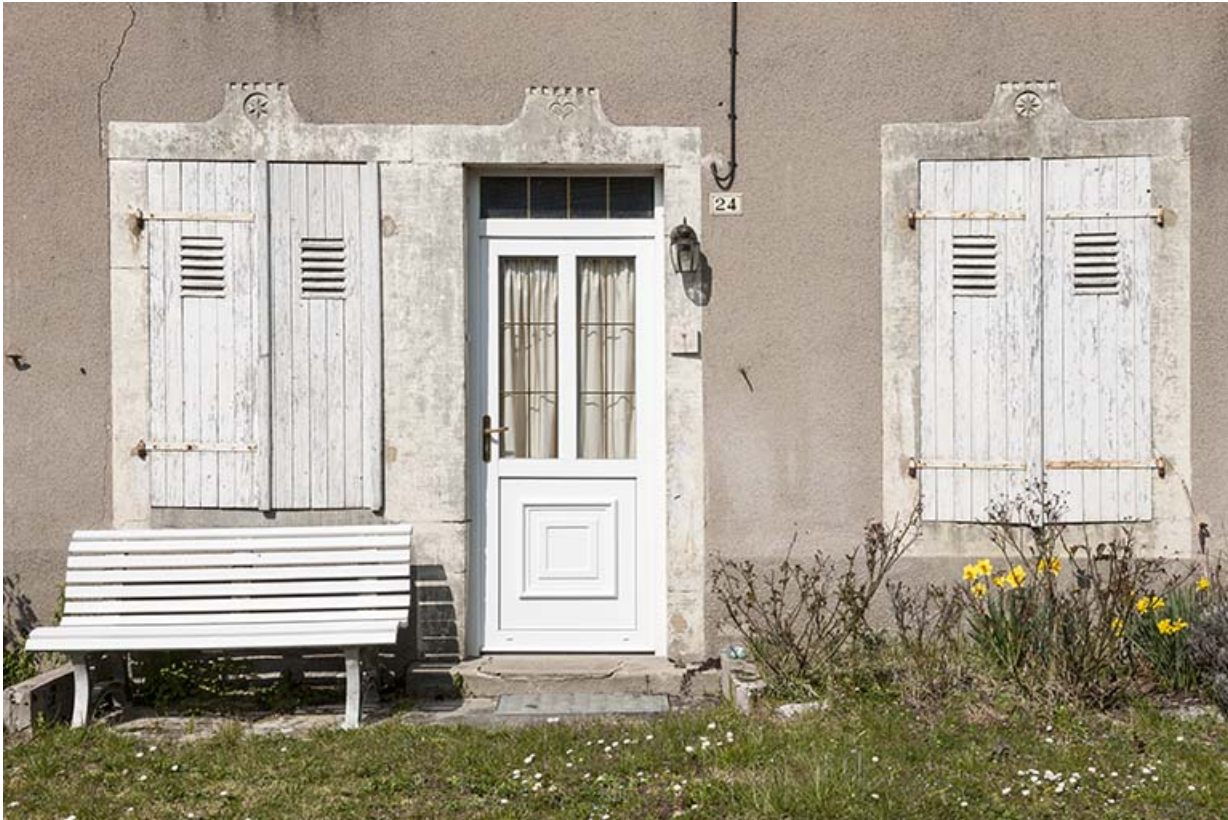
Porte d'entrée, façade principale.
