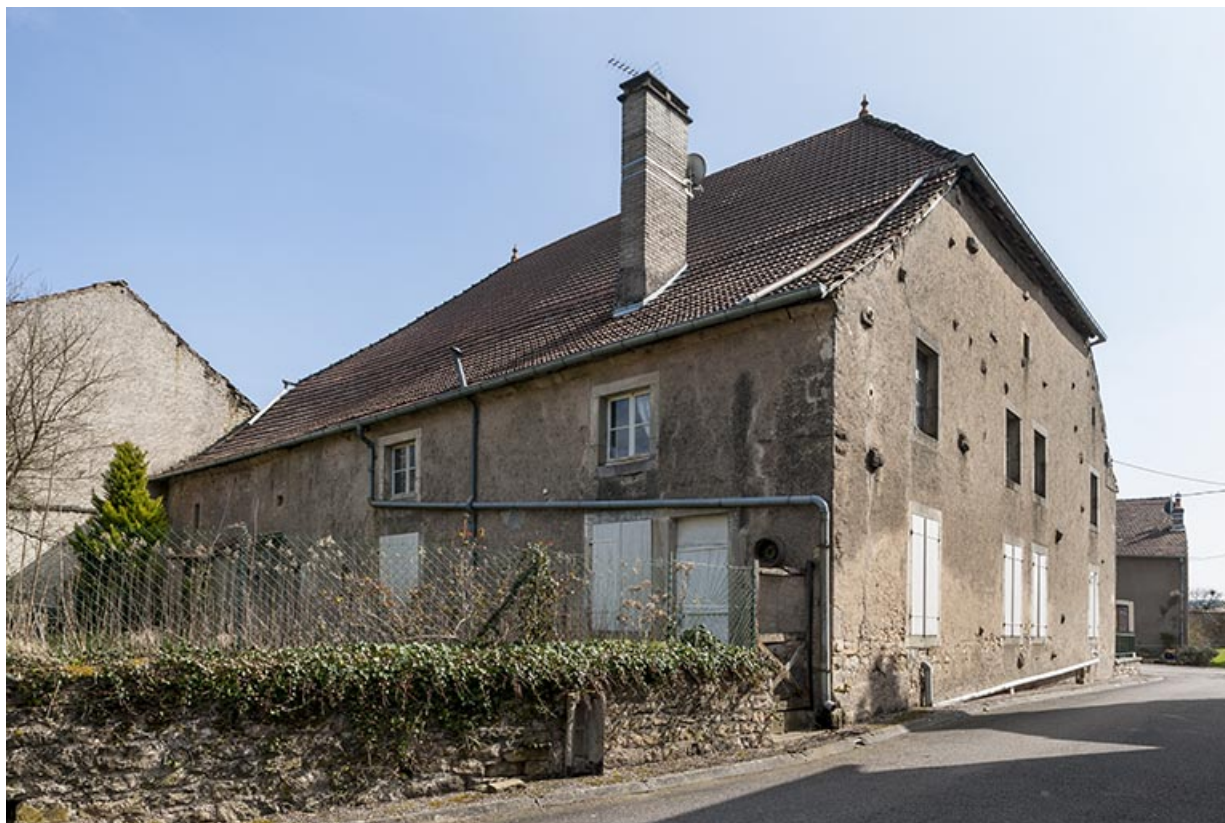
Façade postérieure et mur pignon ouest.
