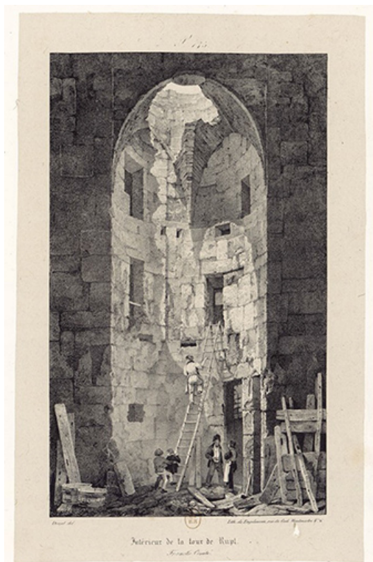
Intérieur de la tour de Rupt. Franche-Comté, 1825. 70, Rupt-sur-Saône, 5 rue de la Garenne
