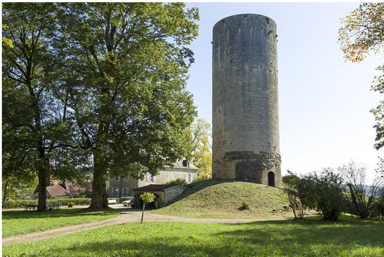
Vue générale du donjon depuis le parc.
