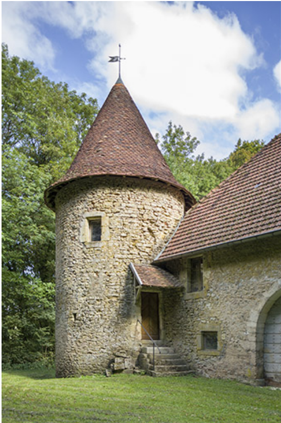
La tour à l'angle nord-est du cuvage.
