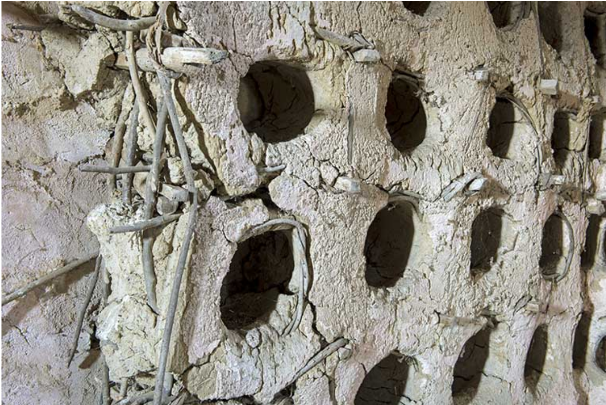
Détail sur la construction des boulins.
