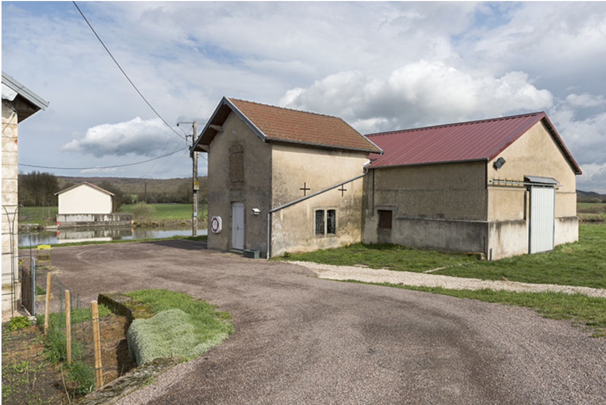
Vue de trois-quart sud du hangar. (Voies navigables de France)
