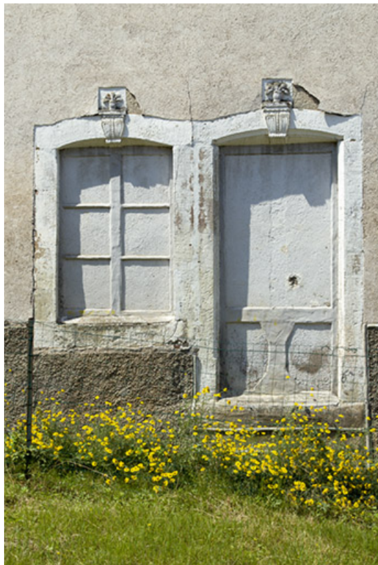
Détail de baies d'une maison d'habitation, 19 rue de la poste. 70, Demangevelle
