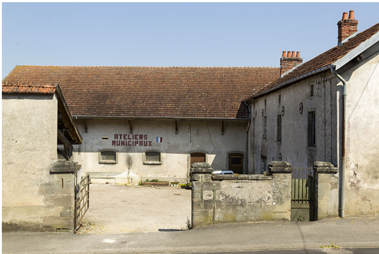
20 grande rue : les ateliers municipaux sont installés dans une ancienne ferme des filatures. 70, Demangevelle
