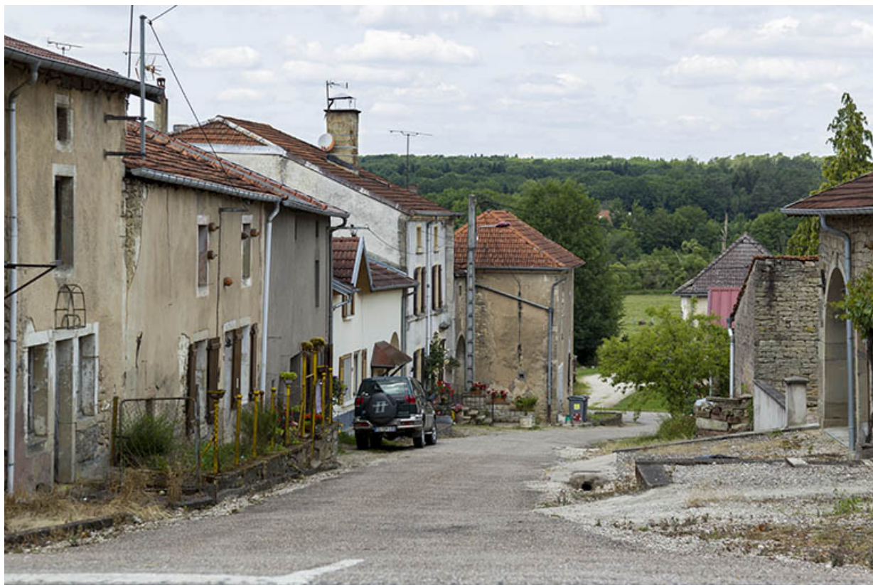
Alignement rue de la fontaine. 70, Demangevelle
