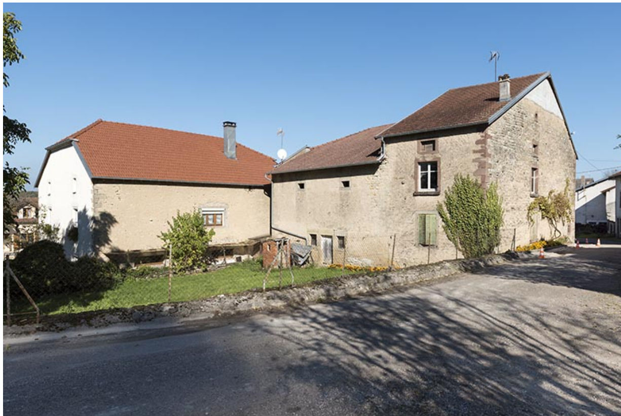
Façade postérieure de la maison 35, grande rue et vue de trois-quart postérieur sud-ouest de la ferme 4 rue du Marchemont. 70, Demangevelle
