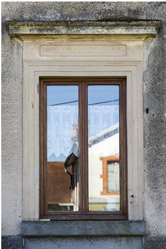
Détail de la baie de l'étage et de l'inscription 2, rue Saint isidore (cette pierre a été posée par Goux et Girardin (?) 1831 (?) 70, Demangevelle
