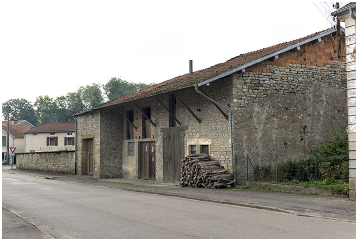
Mur gouttereau de la maison à l'angle du 20 rue Jean Monasson et de la rue Bernard Froeliger. 70, Corre
