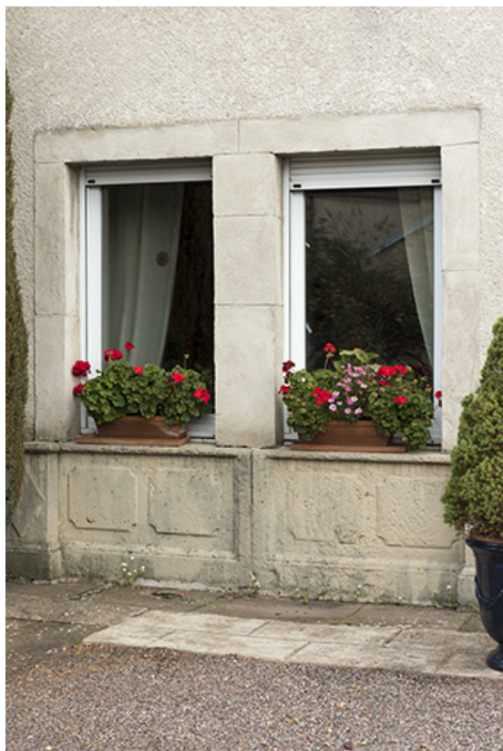
Détail de baie de la maison 6 rue Bernard Froeliger. 70, Corre
