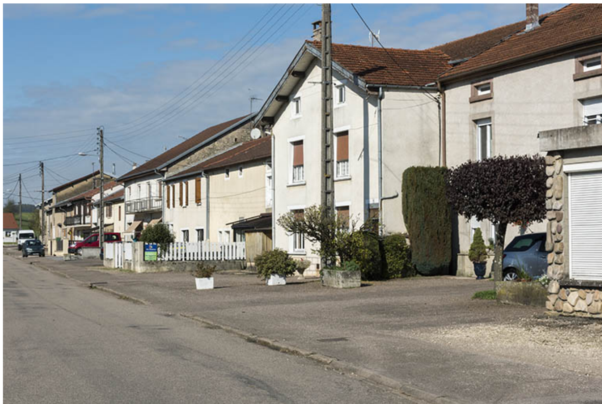
Alignement rive nord-est de la rue Bernard Froeliger. 70, Corre
