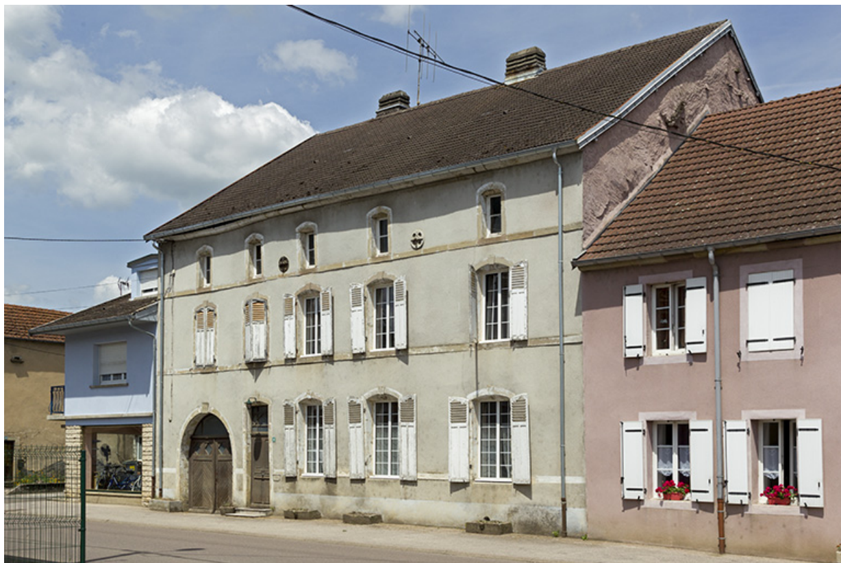
Vue de trois-quart sud-est de la maison 6 rue Jean Monasson 70, Corre, 6 rue Jean Monasson
