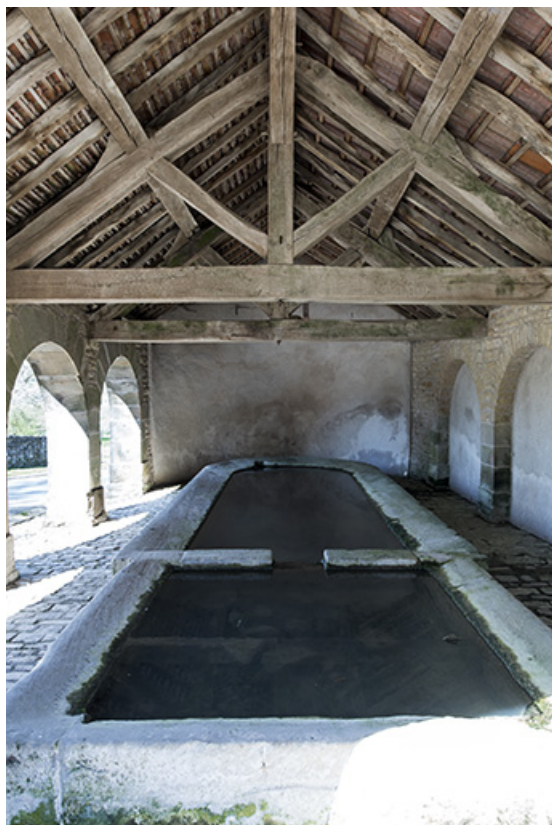
Bassins du lavoir.
