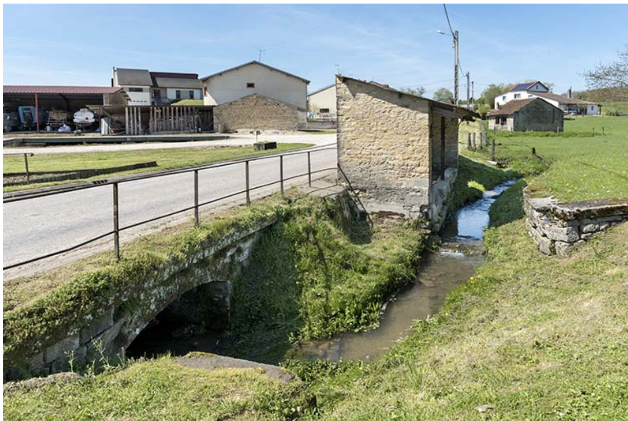
Vue générale du lavoir, Grande rue. 70, Aisey-et-Richecourt
