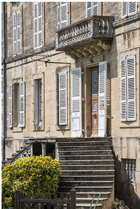
Vue de tris-quarts de la travée centrale, façade sud. 70, Montureux-lès-Baulay, 2, 4 rue de l' Église
