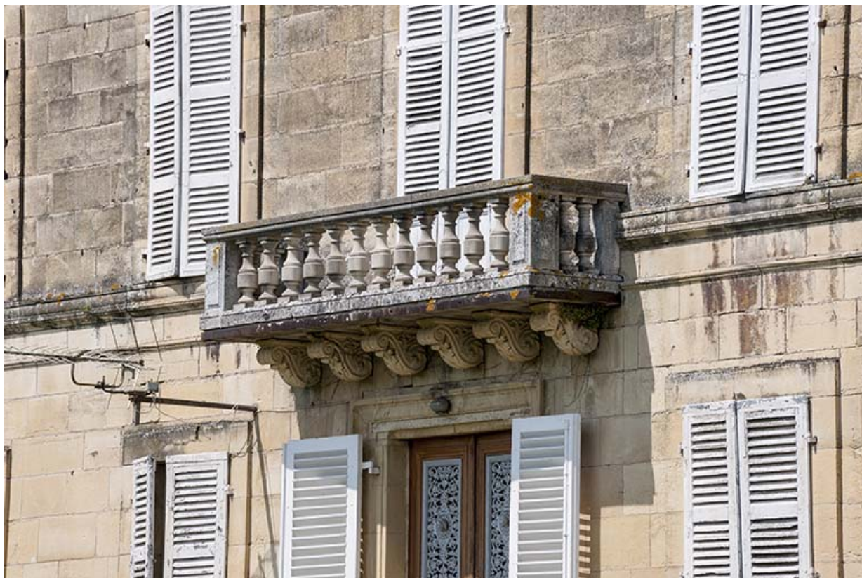
Le balcon au premier étage de la travée centrale, façade sud.
