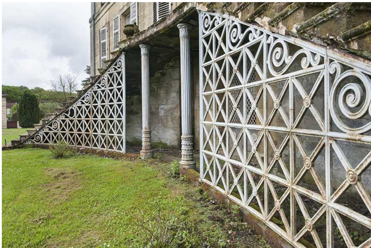
Structure métallique soutenant l'escalier.
